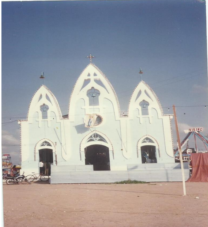
Foto 10 – Capela de Nossa Senhora do Rosário, em 2001
