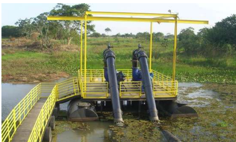
Figura 4 - Captação de água do Perímetro Irrigado do Itiúba no Rio São Francisco
