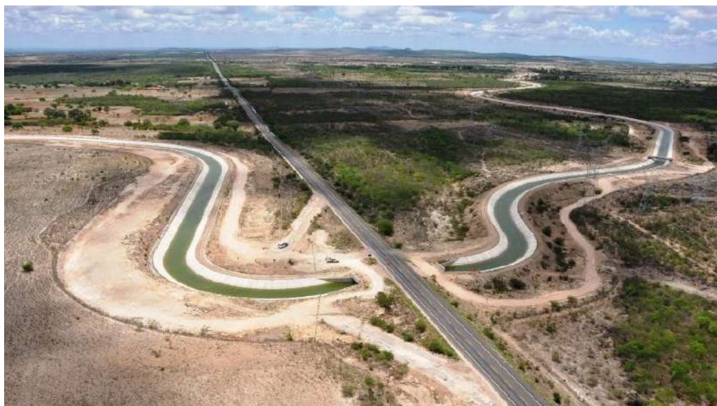
Figura 11 - Canal do Sertão cortando rodovia em Delmiro Gouveia - AL
