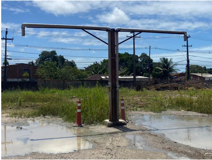
Figura 15 - Instalação hidráulica do novo ponto de carregamento após execução.
