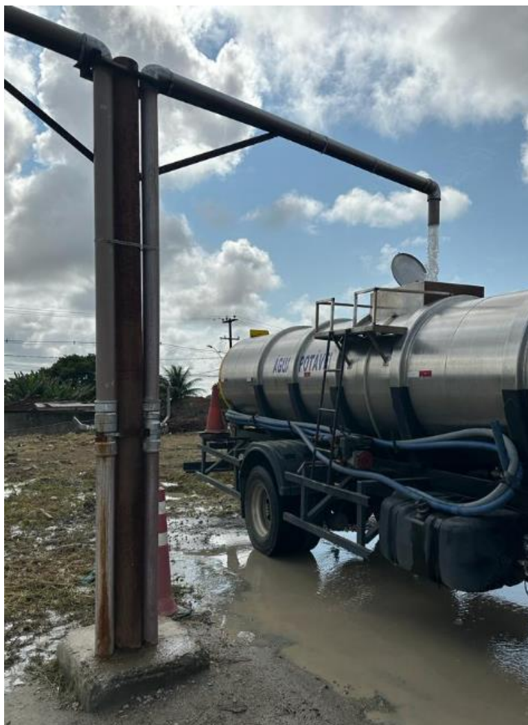
Figura 16 - Instalação hidráulica do novo ponto de carregamento em funcionamento.
