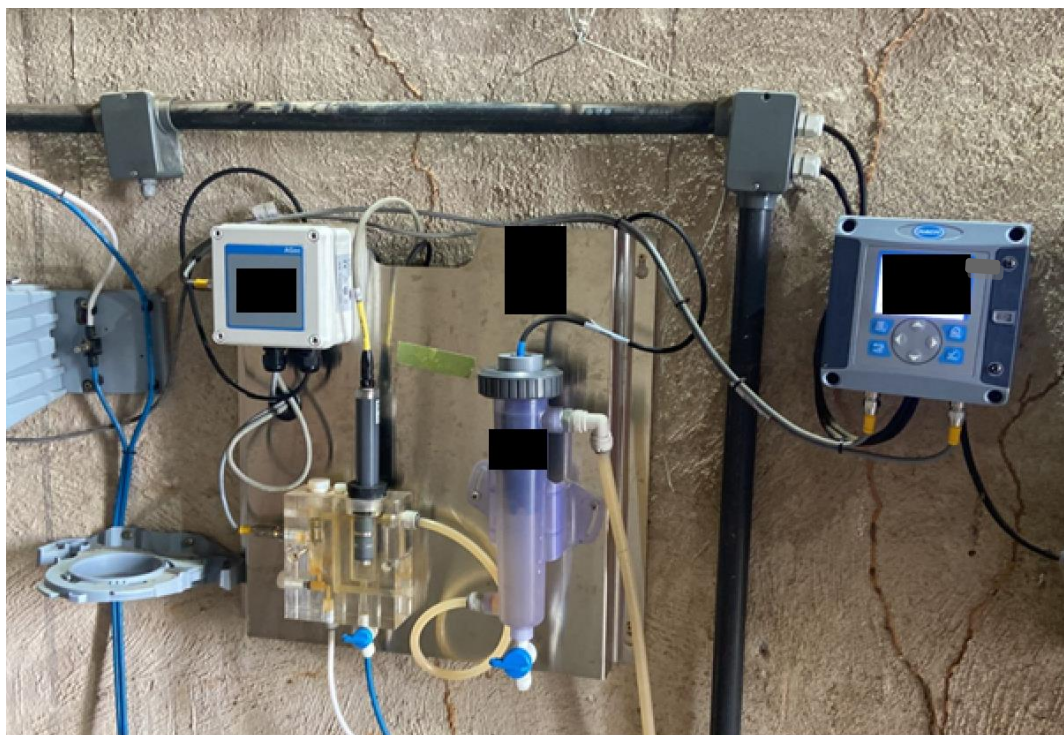
Figura 17 – Dispositivo de análise em tempo real de qualidade da água.
