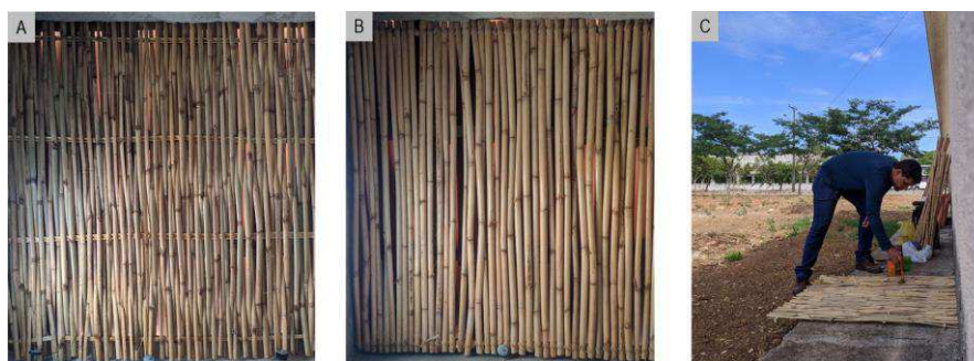
Figura 15 - (A) modelo do bambu trançado – BT, (B) modelo bambu fixado – BF, (C) Processo de envernizamento de um dos forros
