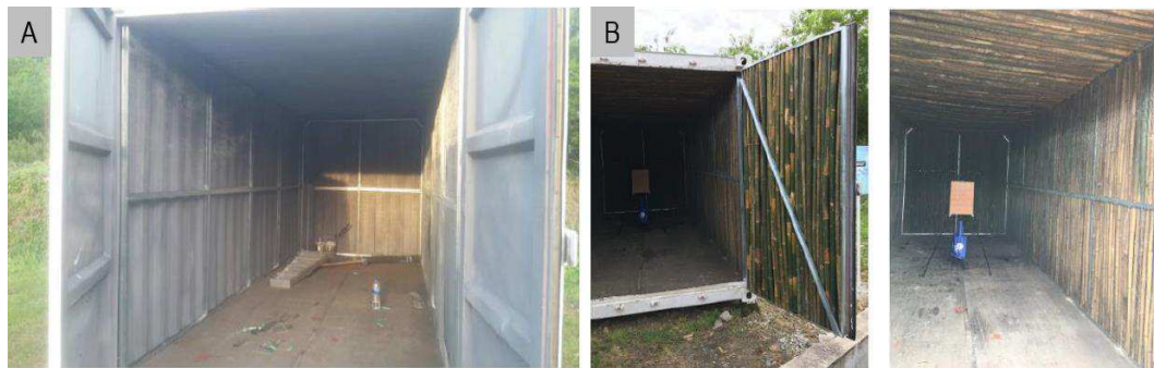
Figura 8 - (A) contêiner sem bambu (B) contêiner revestido internamente com bambu
