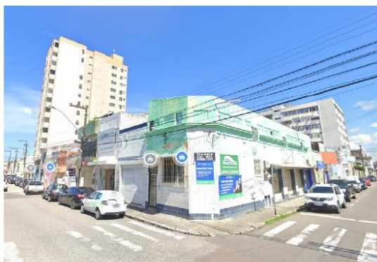
Cruzamento da rua Maruim e rua Santa Luzia
