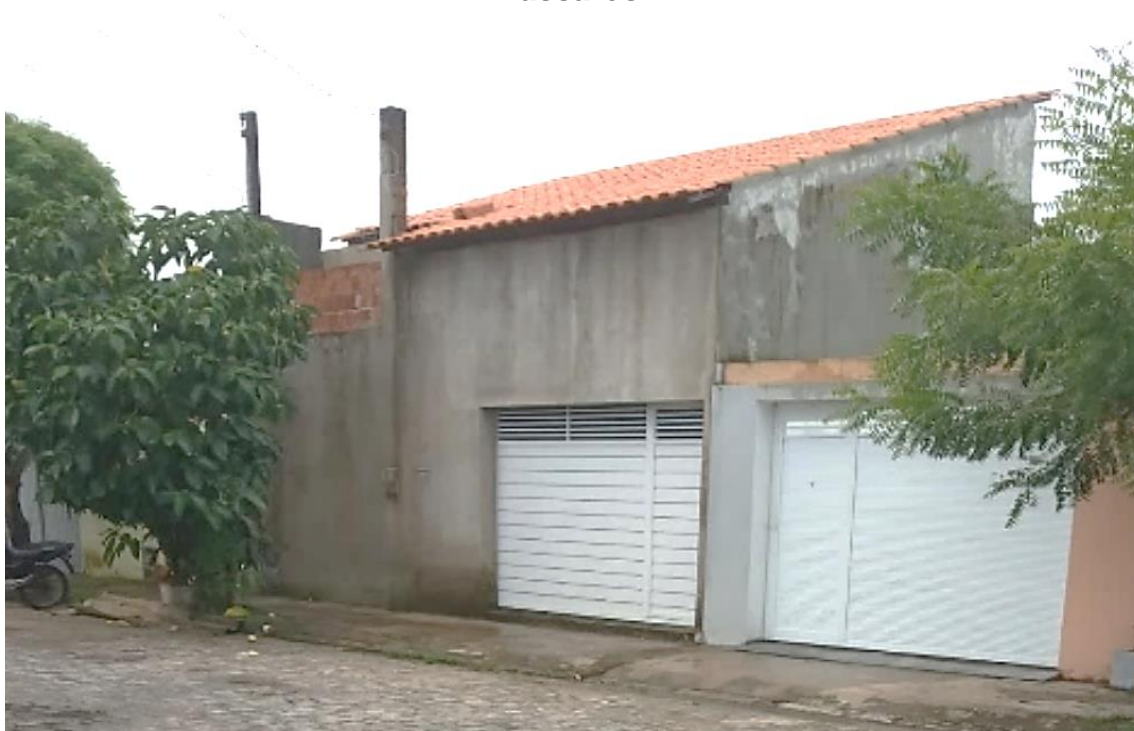
FIGURA 32: Intervenção em Unidade no Residencial Recanto dos Pássaros.
