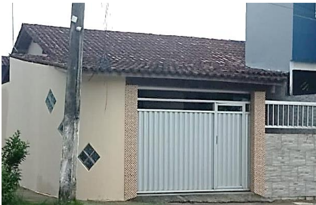
FIGURA 37: Vista da fachada frontal da Casa M1, com destaque para a cobertura com baixa inclinação.
