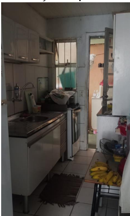
FIGURA 51: Iluminação comprometida na Cozinha.
