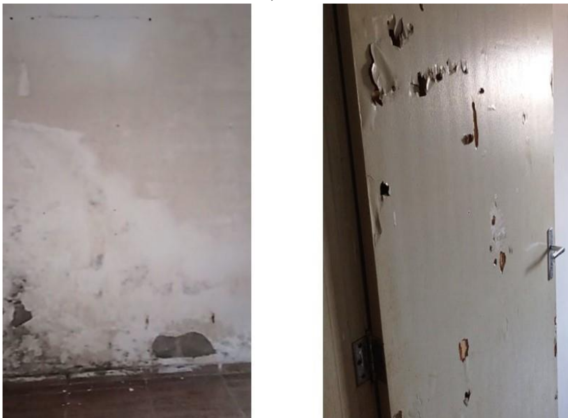
FIGURA 20: Materiais de baixa qualidade utilizados em uma residência do PMCMV, Maceió-AL.
