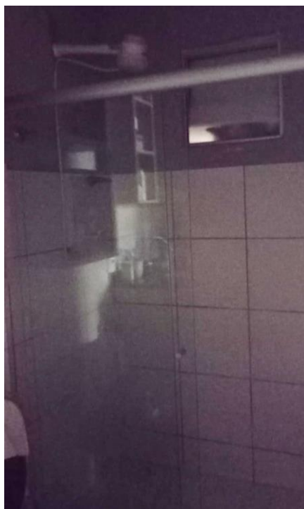
FIGURA 54: Banheiro Social sem iluminação natural.
