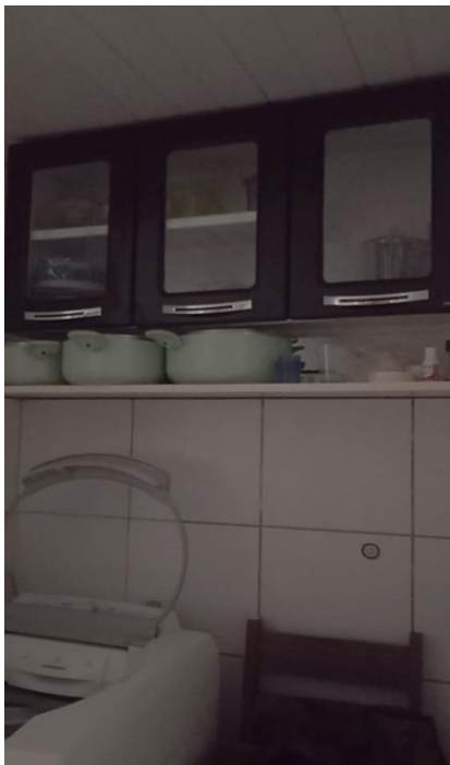
FIGURA 53: Mobiliário obstruindo a esquadria do Banheiro Social.
