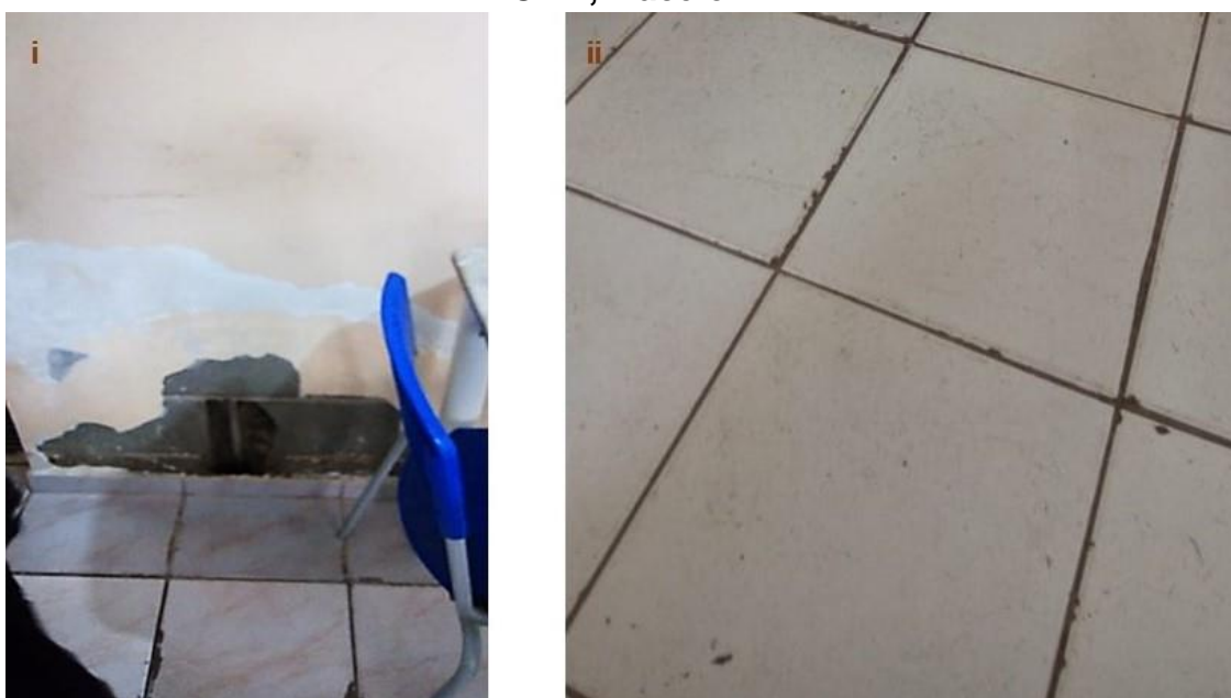
FIGURA 21: Materiais de baixa qualidade utilizados em residências do PMCMV, Maceió-AL.
