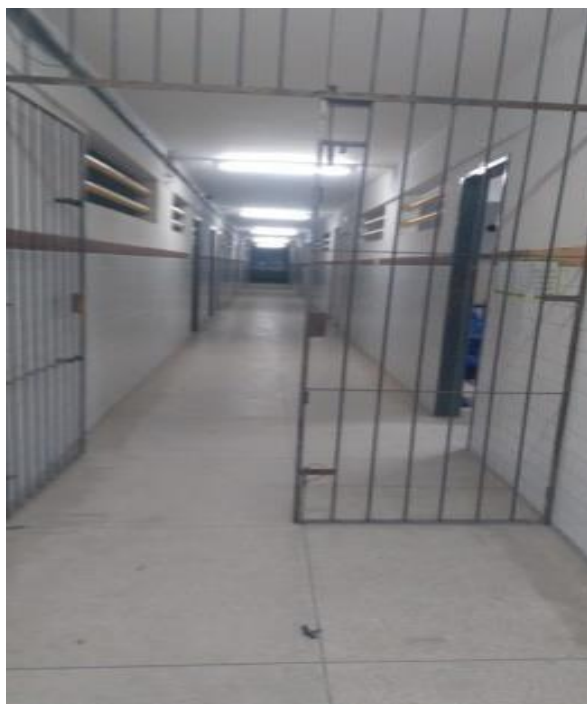
Foto 2 – Corredor de entrada
