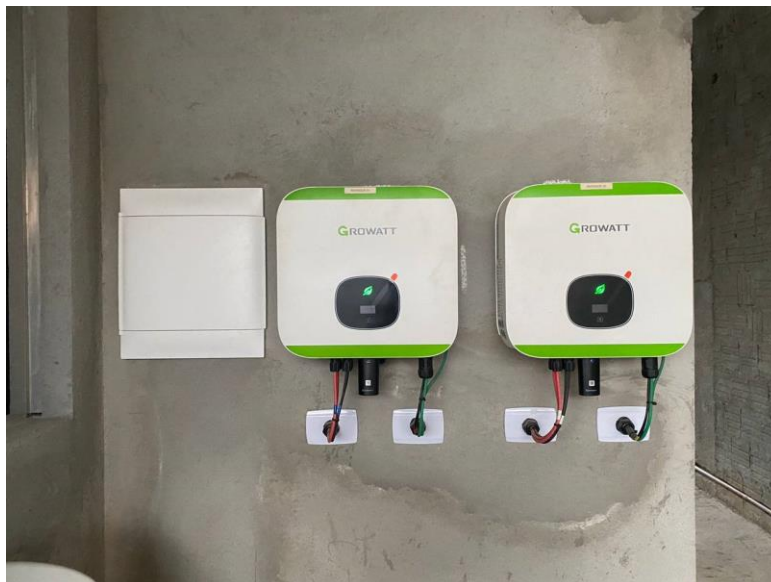
Figura 35 - Instalação do arranjo fotovoltaico ainda na construção
