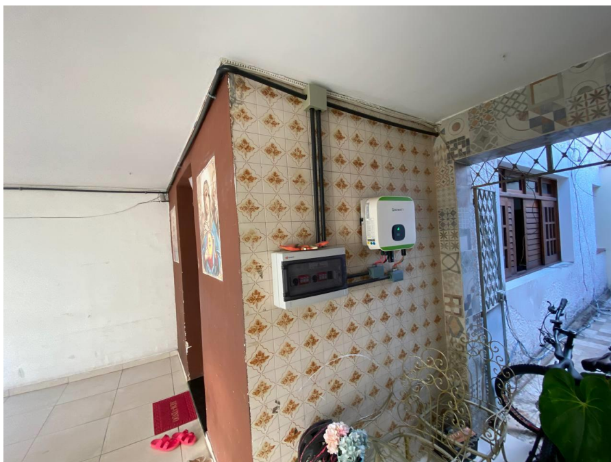
Figura 36 - Instalação do arranjo fotovoltaico após a edificação construída
