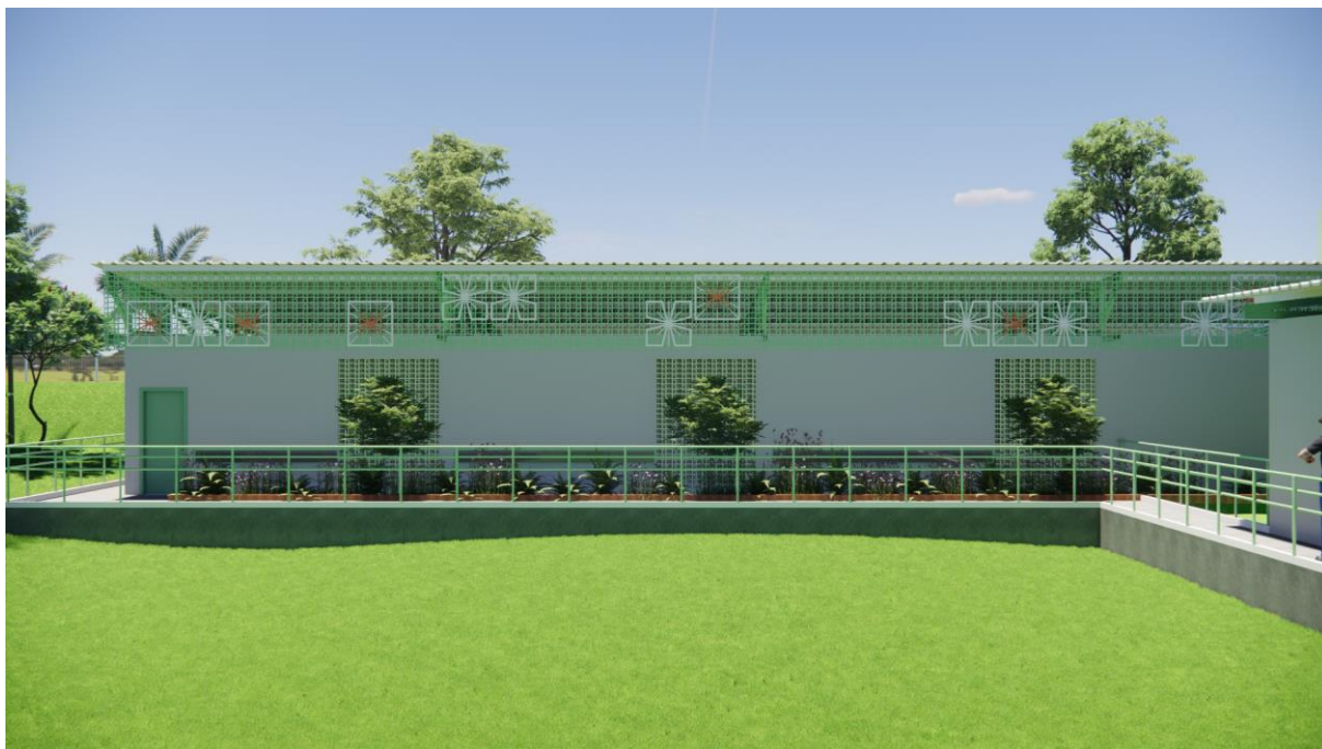
Figura 42: Vista frontal da fachada sul, com a aplicação dos módulos de placas metálicas e aplicação dos módulos de filé. Nessa figura é possível ainda perceber o uso do cobogó para vedação de vãos, e sua proteção feita através de vegetação.
