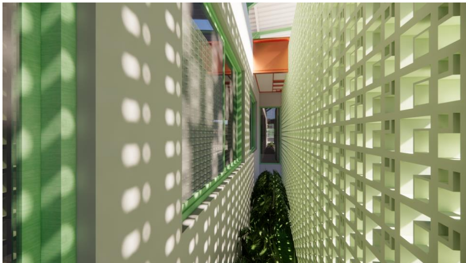
Figura 66: Vista de espaço de transição entre esquadrias da fachada leste e segunda pele em cobogós. Fonte: Elaboração autoral, 2023.
