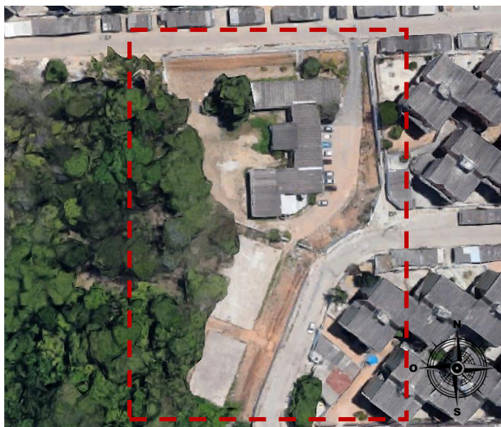
Figura 05: Imagem aérea do prédio da UBS José Tenório. Sem escala Fonte: Google Maps (2023).
