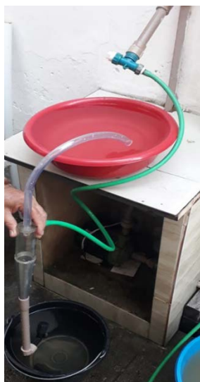
Figura 15: Sistema simples para filtrar a água do poço.
