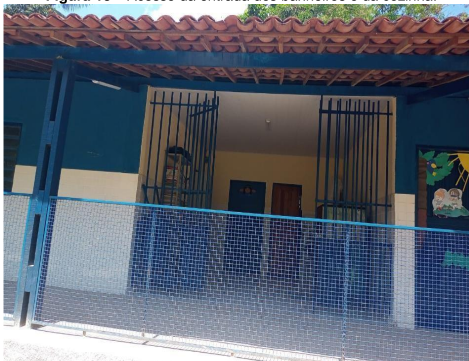
Figura 18 – Acesso da entrada dos banheiros e da cozinha.
