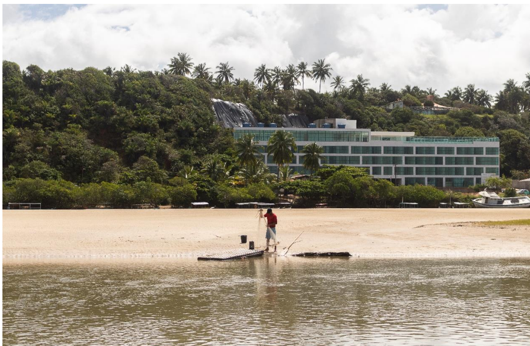
Figura 34 – Resort sendo construído em área de encosta no povoado Barra de Jequiá
