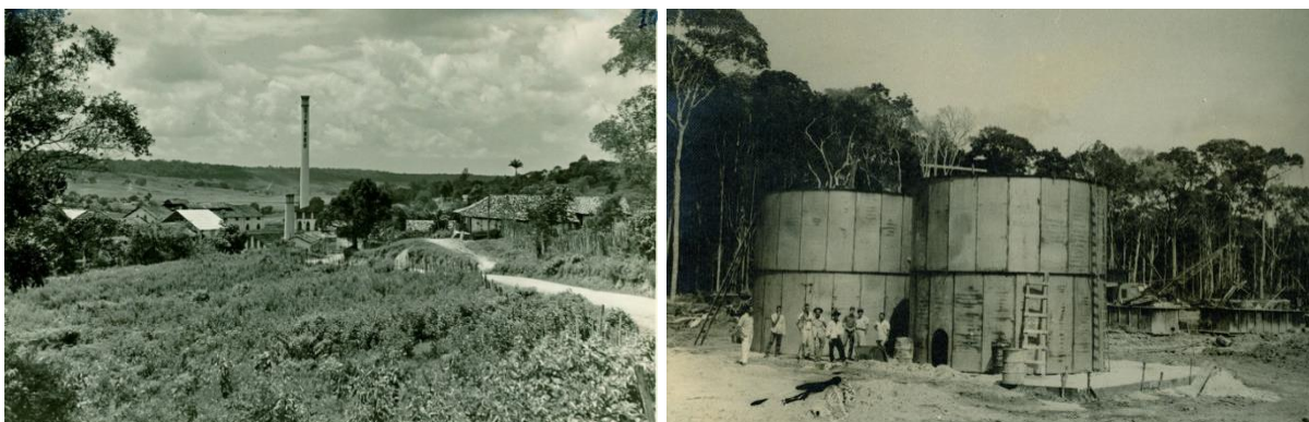
Figura 2 – Usina Sinimbu no início do Século XX, Jequiá da Praia – AL. (A) Vista parcial da usina. (B) Trabalhadores e tanques da usina.
