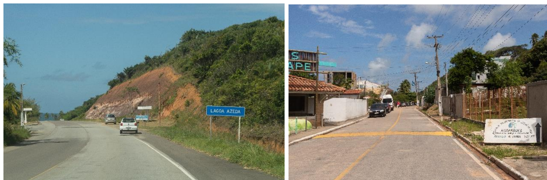
Figura 13 – Sistema viário de Jequiá da Praia-AL. (A) Trecho da AL-101 próximo ao povoado Lagoa Azeda. (B) Rua principal do povoado Barra de Jequiá.
