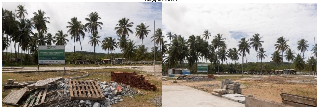
Figura 14 – Urbanização da orla lagunar na sede municipal de Jequiá da Praia. (A) Entulhos da obra de urbanização da orla lagunar. (B) Vista panorâmica da orla lagunar.
