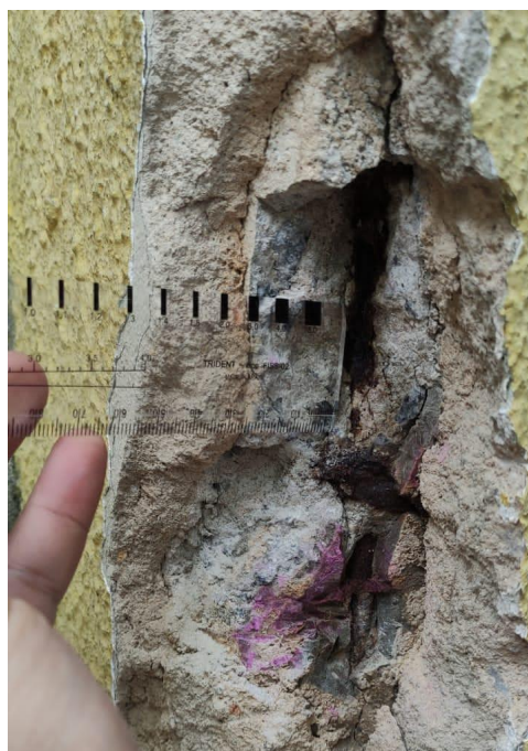
FIGURA 8 - Medição da espessura do cobrimento da armadura
