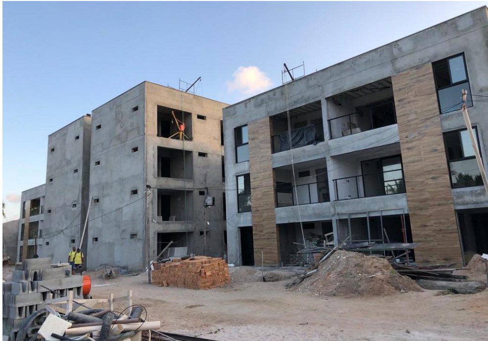
Figura 7 - Fase da obra utilizada no estudo de caso
