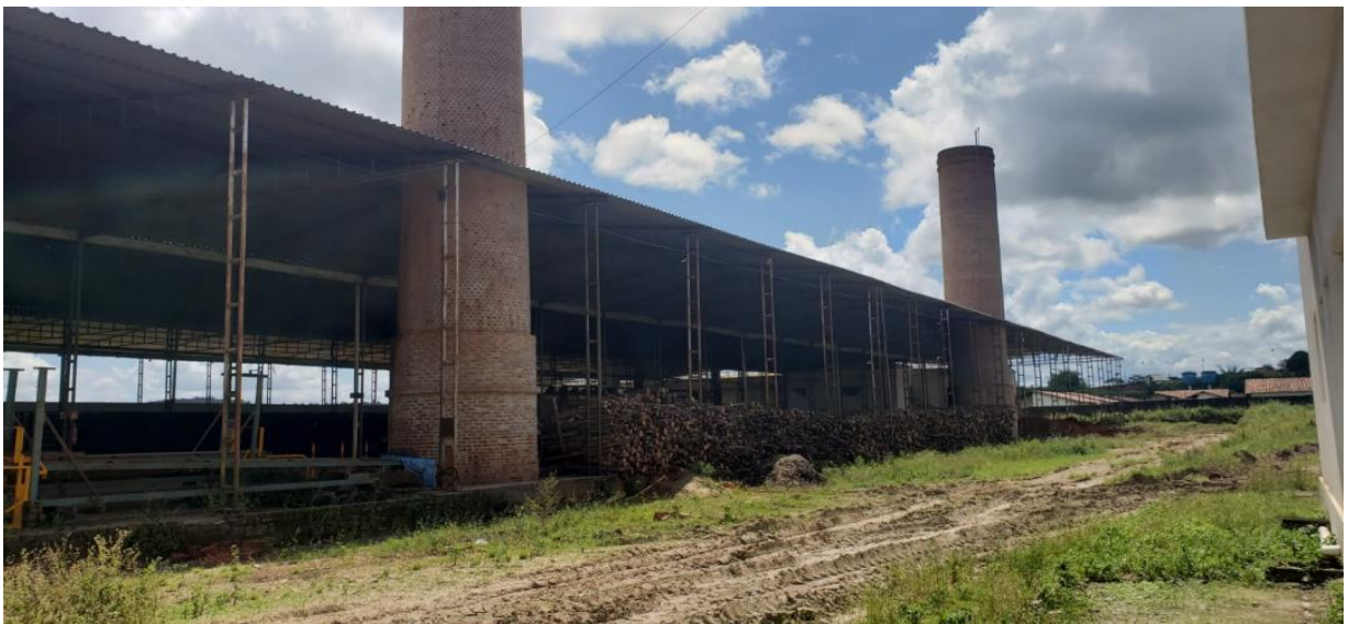
Figura 4 - Vista Geral da Cerâmica Alagoas.
