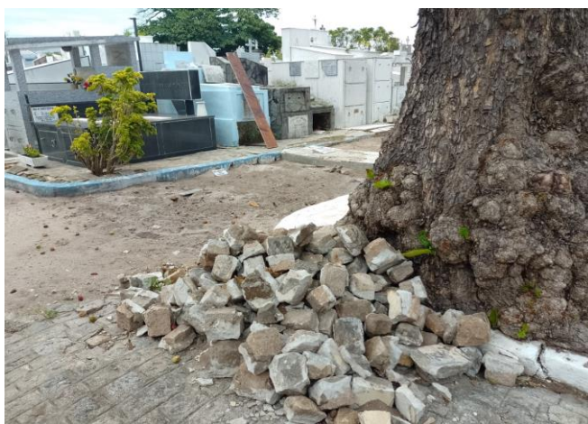
Figura 20 – Retirada de calçamento em ruas do Cemitério da Piedade
