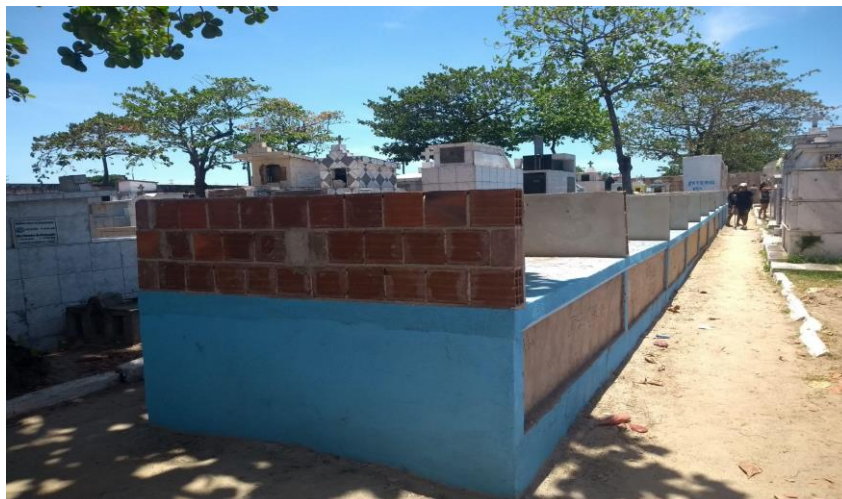
Figura 25 - Gavetas em construção no Cemitério São José
