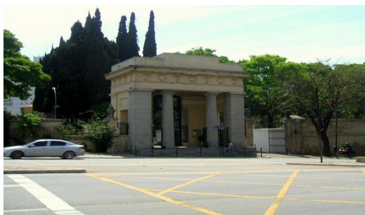
Figura 5- Pórtico de entrada do Cemitério da Consolação
