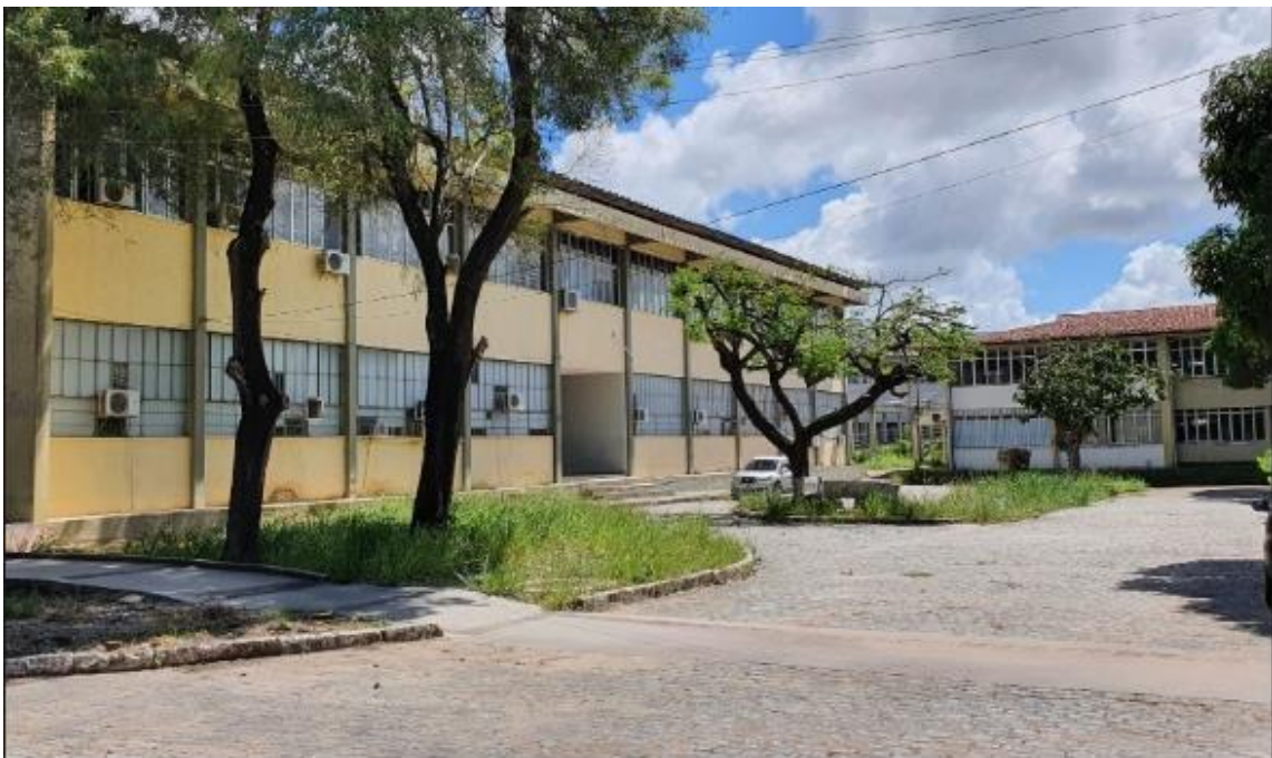
Figura 14 – Visão da sede administrativa e do bloco anexo.
