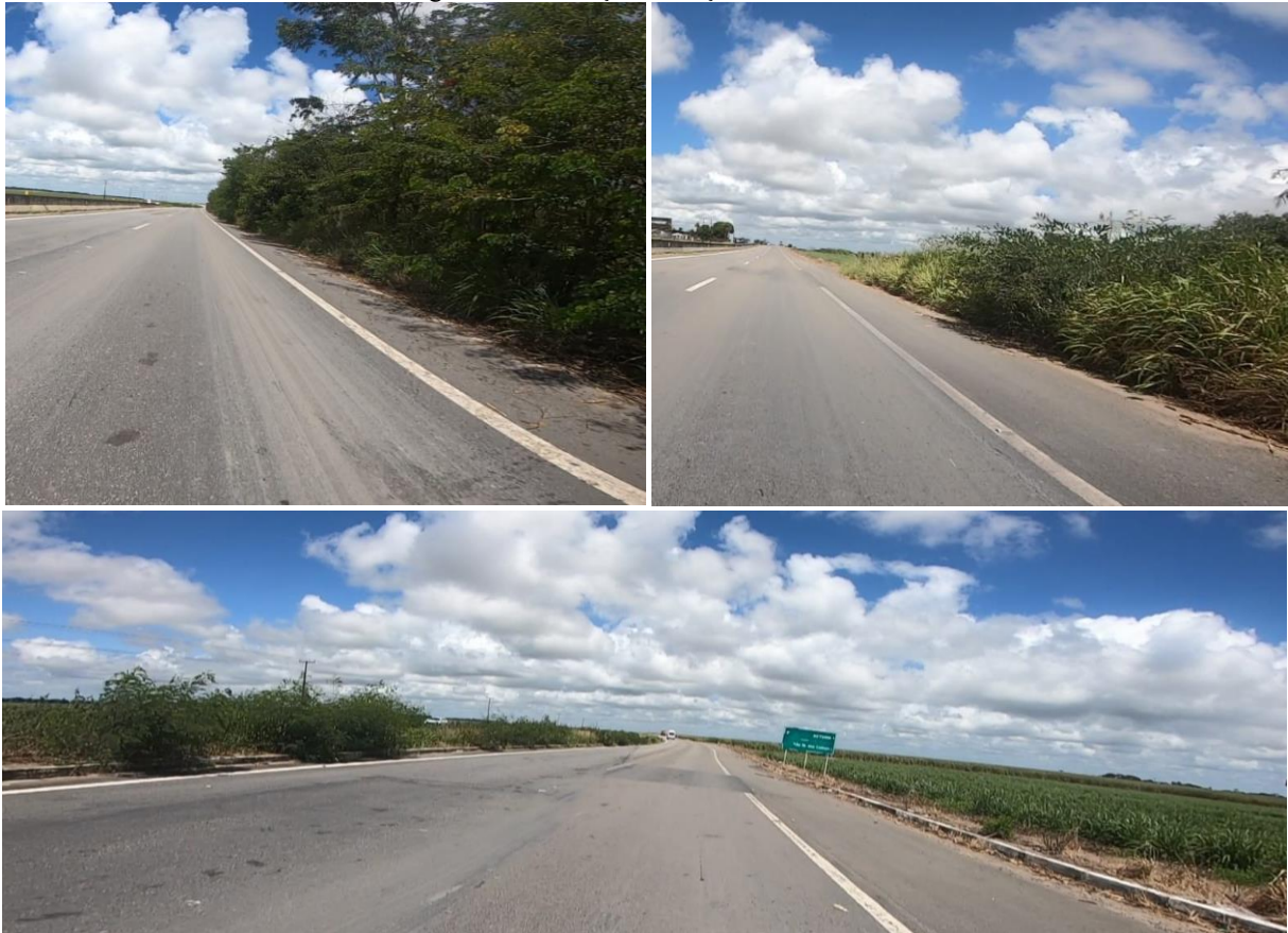
Figura 18 – Situação da roçada na rodovia
