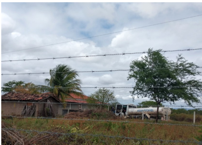
FOTO 4 – CAMINHÃO-PIPA DESCARREGANDO ÁGUA NA CISTERNA DA ESCOLA DESATIVADA
