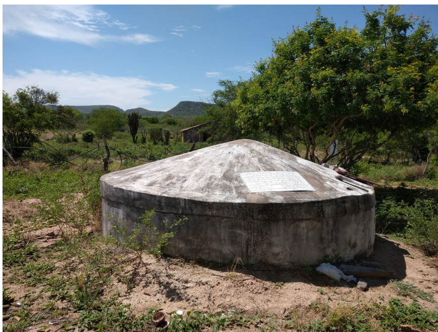
FOTO 7 – CISTERNA DE PLACA CONSTRUÍDA PELAS MULHERES DO COLETIVO
