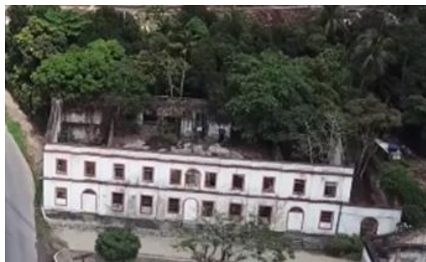
Figura 93 – Vista aérea do prédio administrativo.
