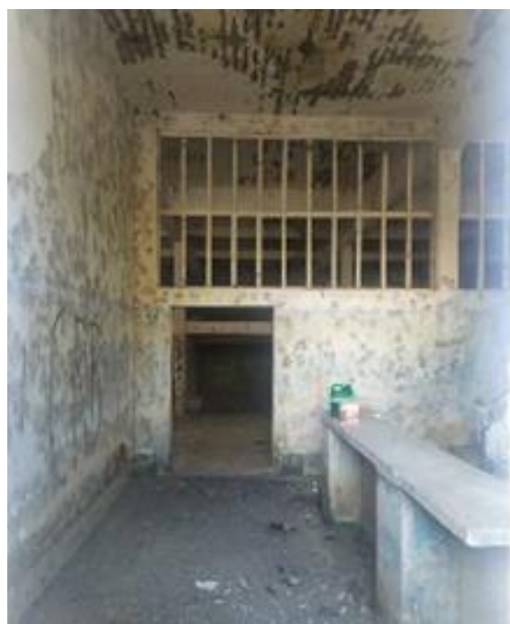
Figura 94 – Vista interna do térreo do prédio administrativo.
