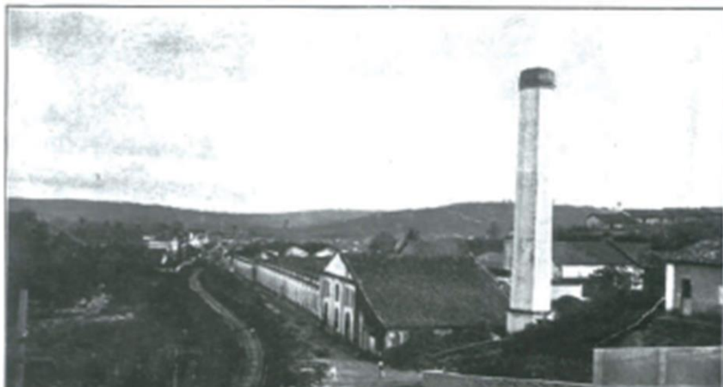
Figura 11 – Vista geral da Fábrica Progresso.
