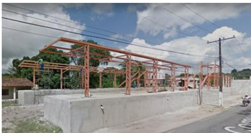
Figura 98: Ampliação da estação ferroviária Gustavo Paiva em estrutura metálica.
