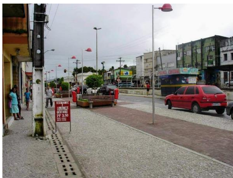
Figura 29: Calçadão da rua do Comércio que foi destruído pela enchente de 2010, Rio Largo/AL.
