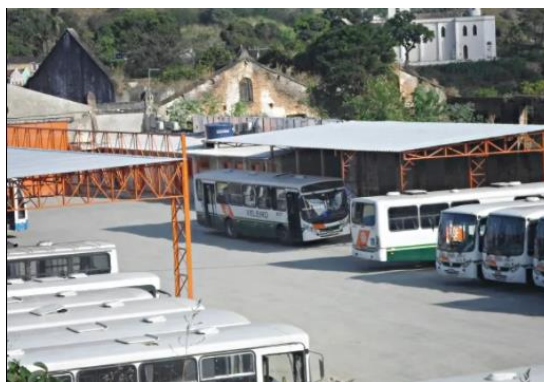
Figura 89: Acréscimo de piso cimentado e cobertura metálica para abrigar ônibus.
