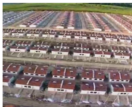
Figura 34: Conjunto Habitacional Barnabé.
