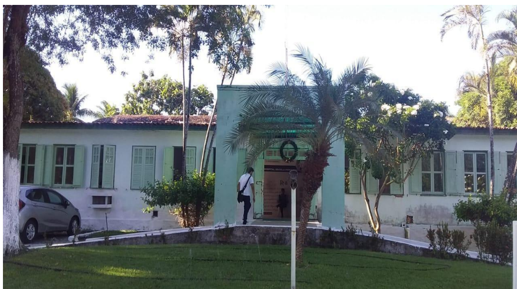
Hospital Psiquiátrico Portugal Ramalho, Bairro Farol. Maceió-Alagoas, Fonte: Acervo Pessoal.
