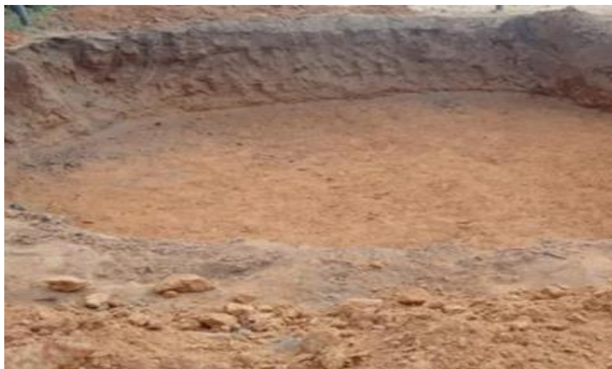
Foto 03: Início da construção das cisternas
