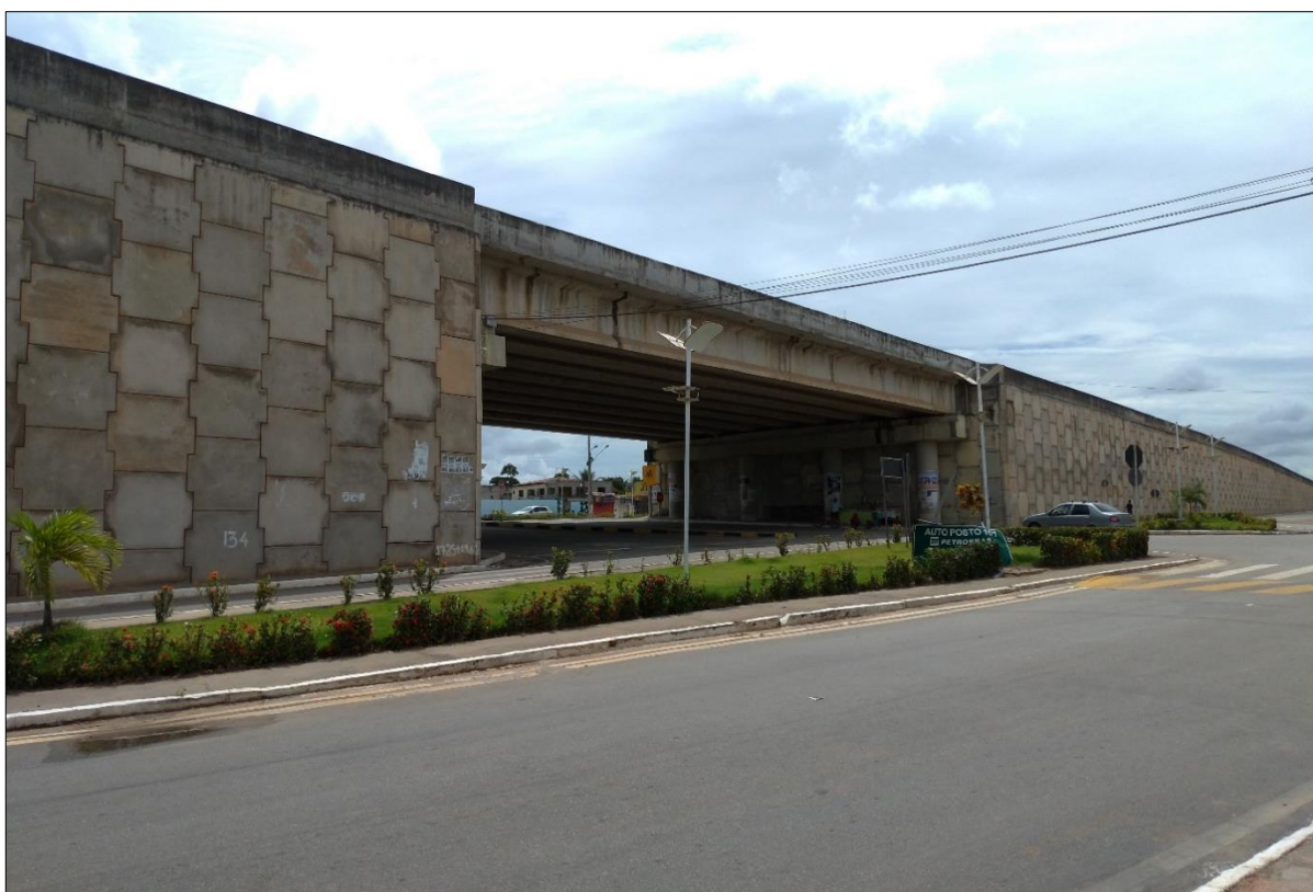
Foto 1 - Viaduto da Rodovia BR-101, em Teotônio Vilela - AL
