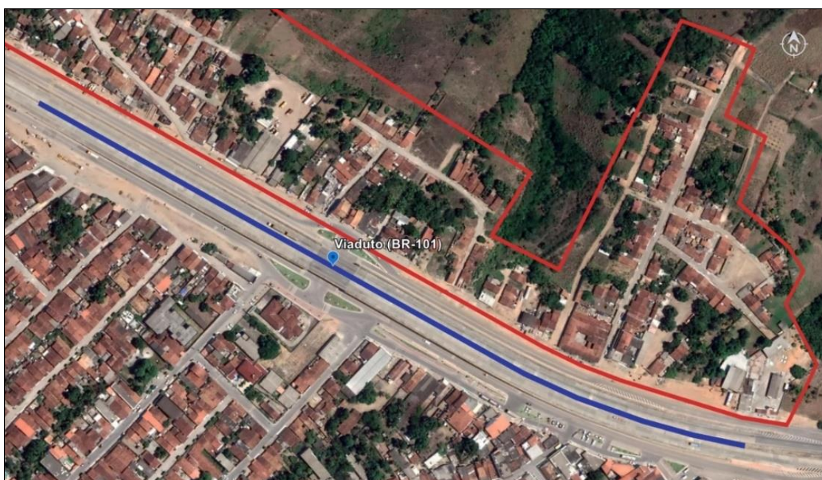
Figura 3 - Demarcação do trecho correspondente a elevação da Rodovia BR-101
