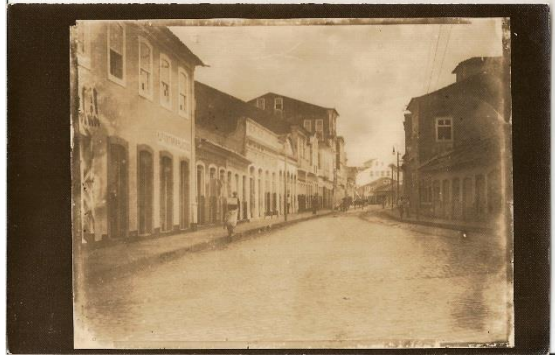
Figura 01 – Trecho da rua do Comércio
