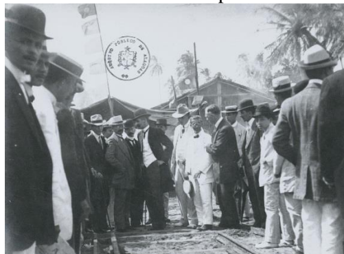
Figura 34 – Assentamento de trilhos para o bonde elétrico 1913
