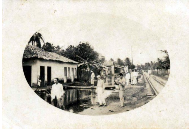
Figura 02 – Trecho da Avenida Buarque de Macedo
