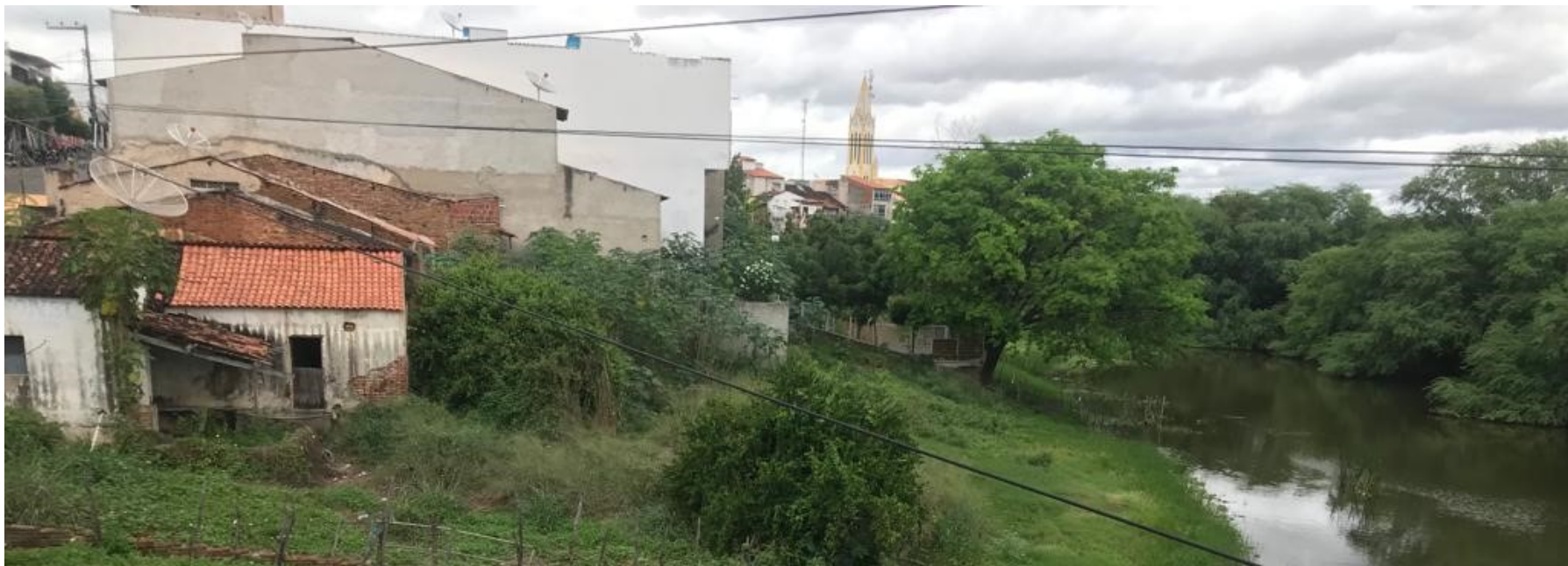
Figura 03: Fotografia da margem no rio Banabuiú ocupada em parte por edificações no bairro do Centro de Mombaça, com Igreja da Matriz ao fundo.
