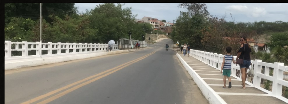
Figura 19: Fotografia C, da ponte que conecta os bairros Vila Batista ao bairro do Centro. Circulação de pedestre elevado, a direita da ponte. Fonte: Autor, 2020
