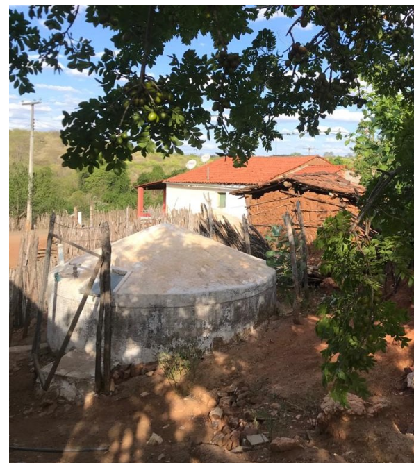
Figura 09: Cisterna parcialmente enterrada na comunidade de Capivara, povoado na área rural de Mombaça.
