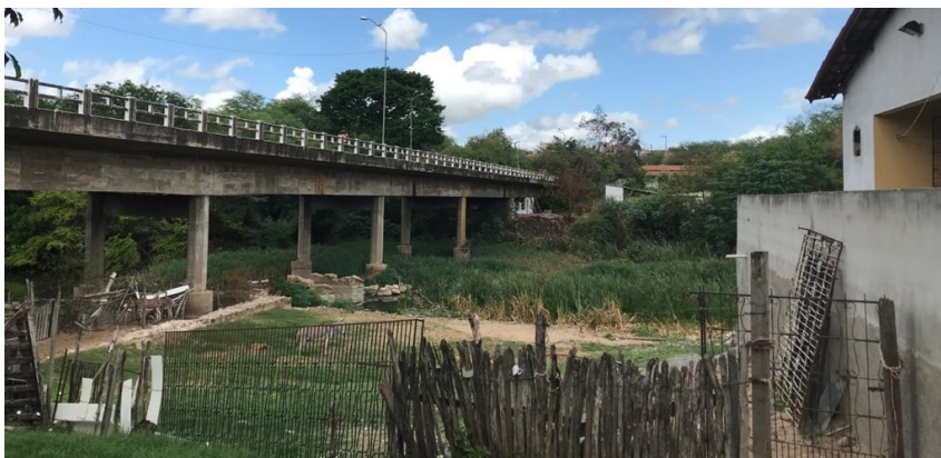
Figura 11: Margem do rio Banabuiú, vista desde o Bairro do centro com ponte que conecta com Bairro Vila Batista. Destaque para a mata ciliar retirada, ocupação por edificação na margem e bloqueio no acesso ao rio.
