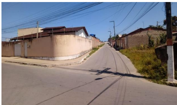
FOTO 2 – RUA ANTONIO SERAFIM COSTA COM ENTRADA DO CONJUNTO MACEDÔNIA À DIREITA EM 2019.
