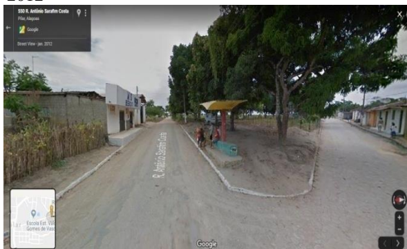
FOTO 1 – RUA ANTONIO SERAFIM COSTA COM ENTRADA DO CONJUNTO MACEDÔNIA À DIREITA EM 2012
