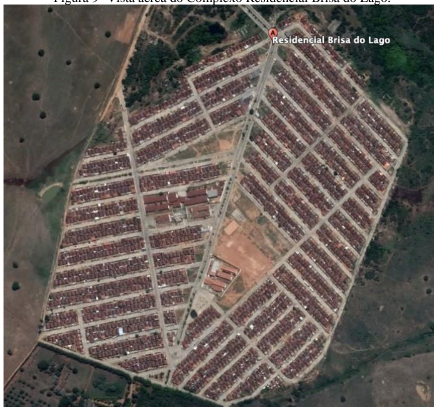
Figura 9- Vista aérea do Complexo Residencial Brisa do Lago.
