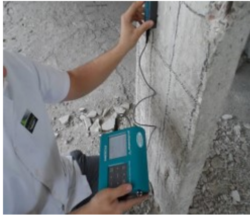
Figura 2.5 – Avaliação de estrutura de concreto com pacômetro
