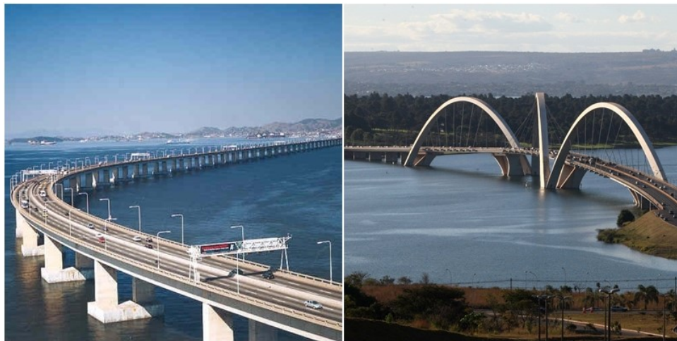
Figura 2.10 – Ponte Rio-Niterói (à esquerda) e Ponte JK (à direita)
