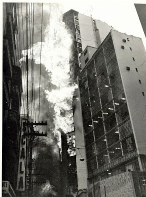
Figura 1.2 – Incêndio no edifício Andraus, em São Paulo
