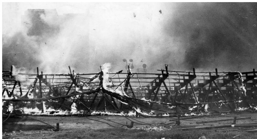
Figura 1.1 – Incêndio no Gran Circo Norte-Americano, no Rio de Janeiro
