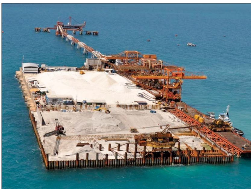
Figura 3 – Ampliação da ilha artificial do Terminal Salineiro de Areia Branca (RN).
