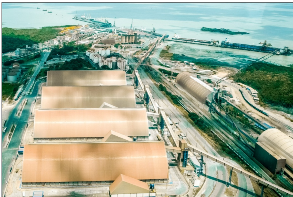
Figura 2 – Armazéns do Terminal de Grãos do Maranhão no Porto do Itaqui (MA).
