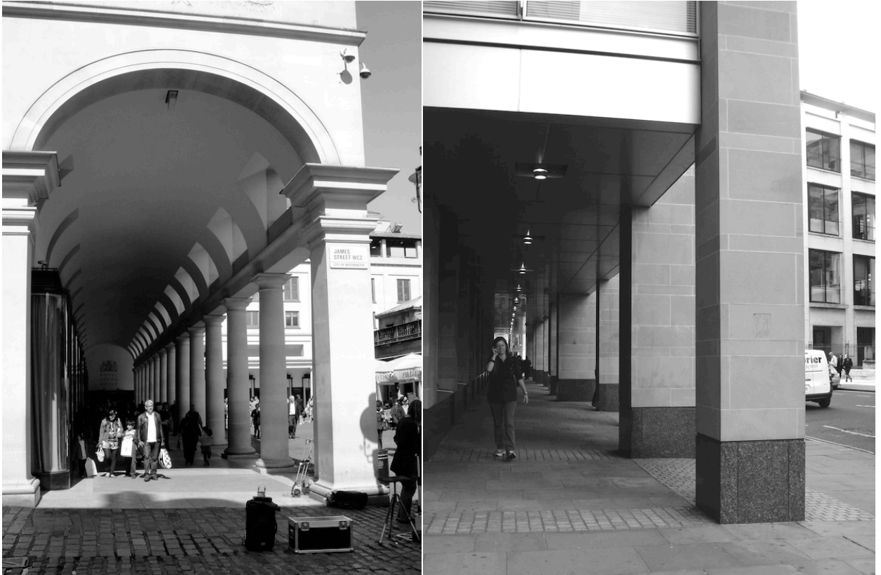
Fotos 2.1.22 e 2.1.23 – Galerias na Convent Garden e Newgate, Londres, Inglaterra, mai. 2011.
