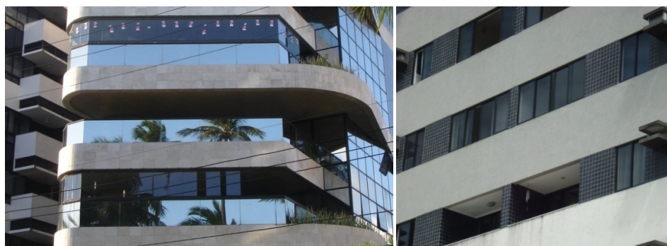
Figura 17 – Integração das varandas com a sala através de fechamento de vidro nos edifícios Rodin e Piazza Navona, Ponta Verde, Maceió/AL.
