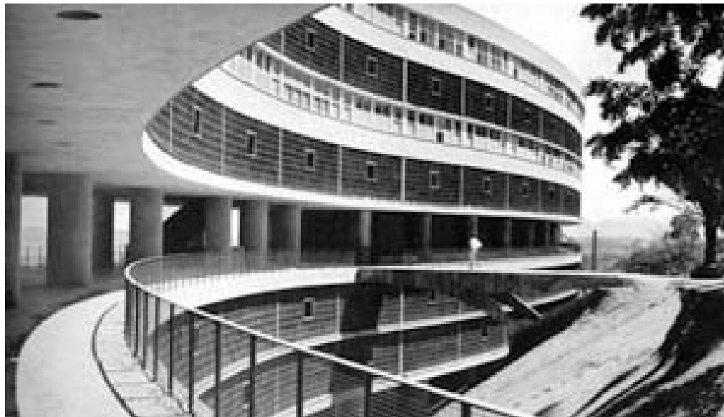
Figura 15 - Fachada posterior do Conjunto Mendes de Moraes, o “Pedregulho”, projetado pelo arquiteto Affonso Eduardo Reidy, adaptada à insolação intensa.
