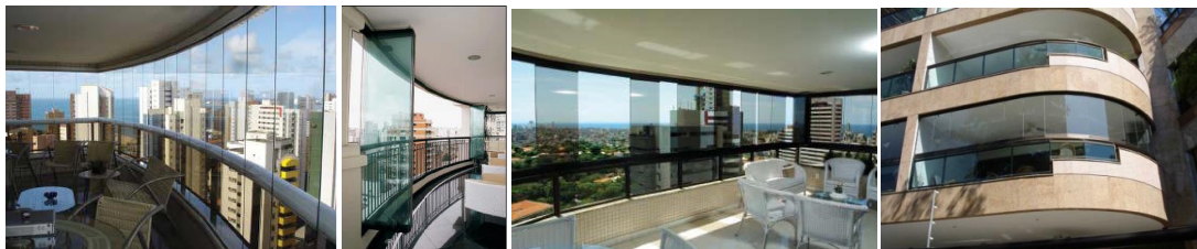
Figura 27 - Fechamento de varandas em vidro temperado.
