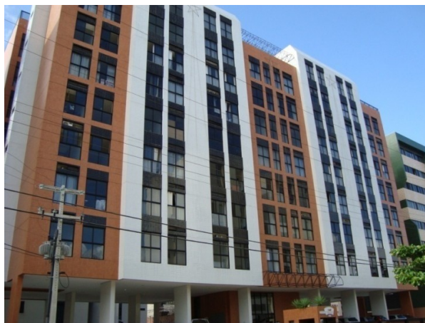
Figura 16 – Inexistência de varandas no edf. Maranello, Ponta Verde, Maceió/AL. Fonte: A autora (2009).
