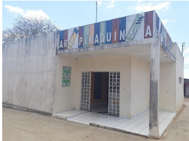
Figura 2 - Fachada Arapiraquinha III
