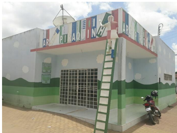
Figura 3 - Fachada Arapiraquinha VI
