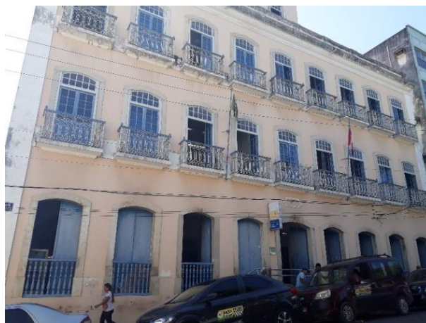
Figura 1 - Fachada da BPEGR
