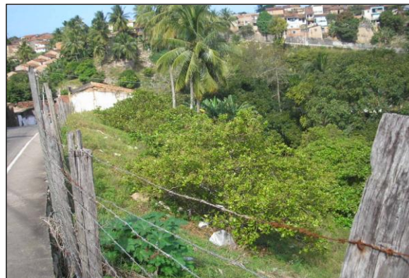
Figura 34 – Ocupação de encostas no bairro do Feitosa Fonte: (LIMA, 2006)
