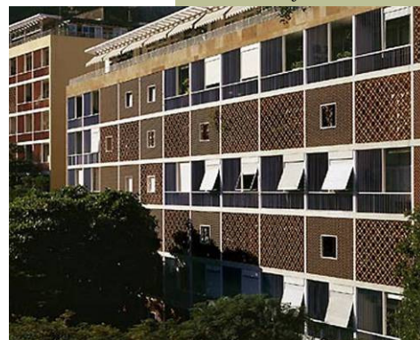
Figura 9 – Conjunto Habitacional Parque Guinle, de Lúcio Costa. Rio de Janeiro, 1948. Composição plástica com a variação de brise-soleils , cobogós , elementos vazados e treliças de madeira.
