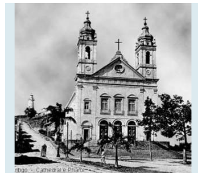
Figura 13 – Igreja Matriz Nossa Senhora dos Prazeres, com o Farol ao fundo, Maceió, s/d. Fonte: MISA.
