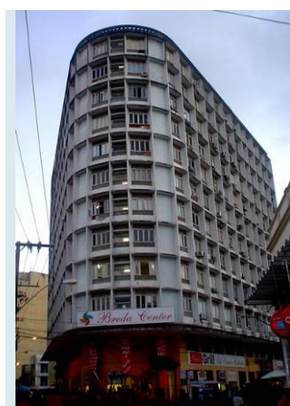
Figura 42 – Edifício Breda, Centro.
