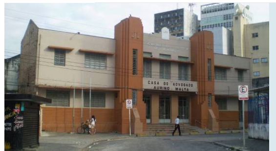
Figura 38 – Antiga Faculdade de Direito de Alagoas, construída em 1934. Atual sede da Ordem dos Advogados do Brasil, Praça Montepio, Centro. Fonte: Acervo Pessoal, 2008.
