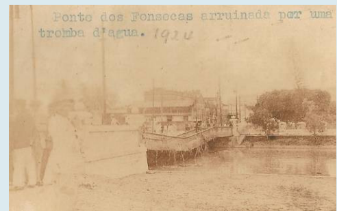
Figura 16 – Ponte dos Fonseca arruinada por uma tromba-d’água, 1924. Fonte: APA.
