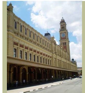
Figura 4– Estação da Luz, São Paulo. Exemplo de arquitetura de importação inglesa em estrutura metálica para construção de estações ferroviárias no século XIX.
