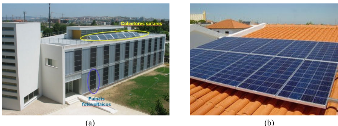
Figura 5.25 – (a) Localização dos painéis e dos coletores solares num edifício; (b) Vista dos painéis fotovoltaicos no telhado de uma residência.
