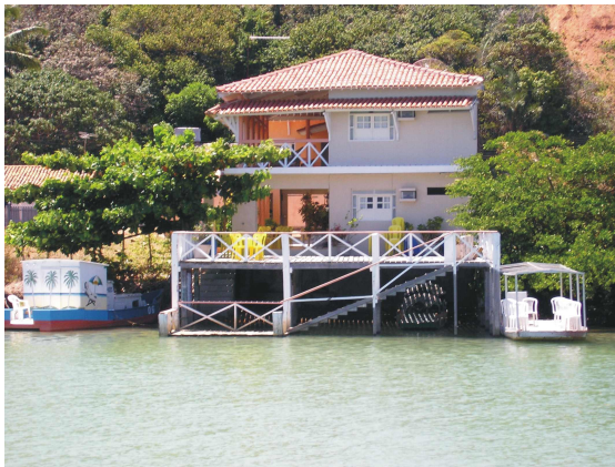
Foto 34 - Pousada Dunas de Marapé que faz parte do Complexo de lazer , em 2003. Fonte: SETURES (2006).
