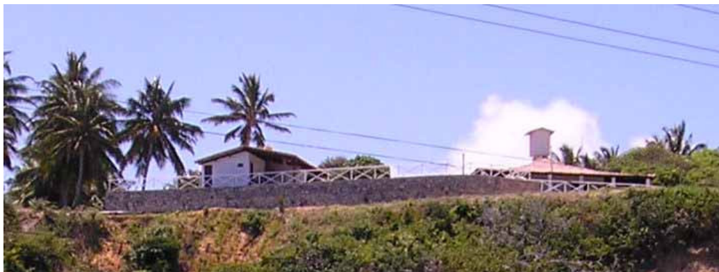
Foto 36 - Vista da Pousada e Restaurante Portal dos Coqueirais. Fonte: SETURES (2006).
