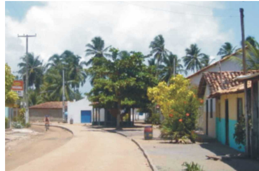
Foto 4 - Rua principal do povoado Barra de Jequiá, pavimentação em execução. Fonte: acervo pessoal, (2007).
