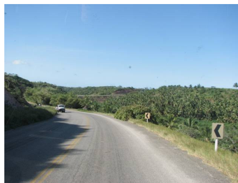
Foto 14 - Trecho da AL-101-Sul, próximo ao acesso do povoado Lagoa Azeda. Fonte: Oliveira, Moisés C. de (2006).
