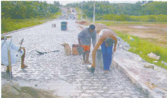
Foto 3 - Obra de pavimentação da estrada de acesso ao povoado Lagoa Azeda. Fonte: Antônio Jequiá, (2006).
