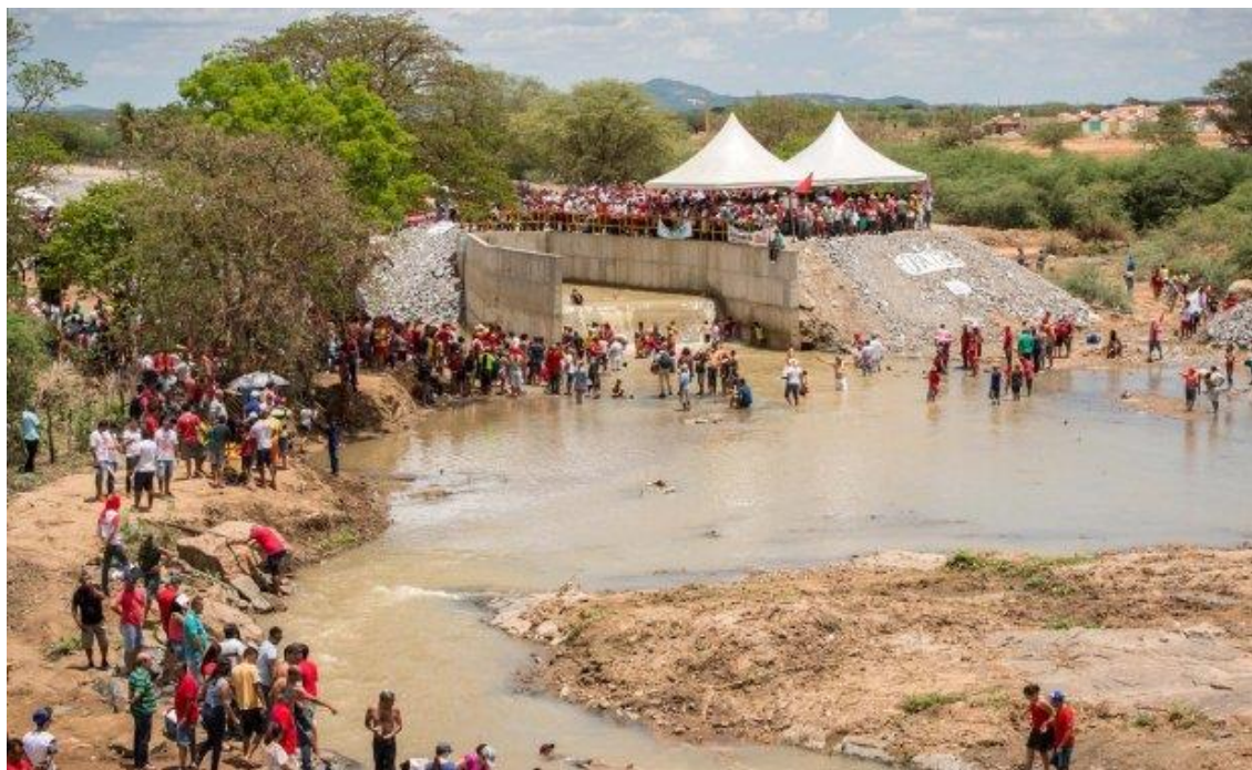
Foto 4: Inauguração do canal Eixo-Leste no Rio do Meio afluente do Rio Paraíba
