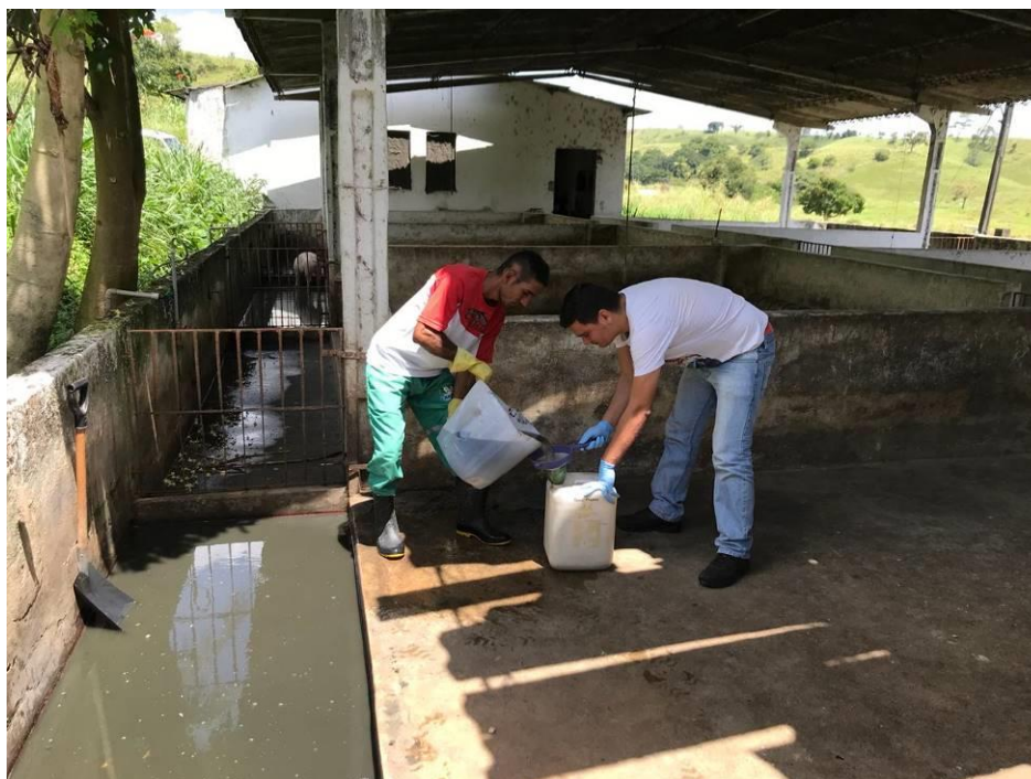
Figura 14 – Separação dos sólidos grosseiros
