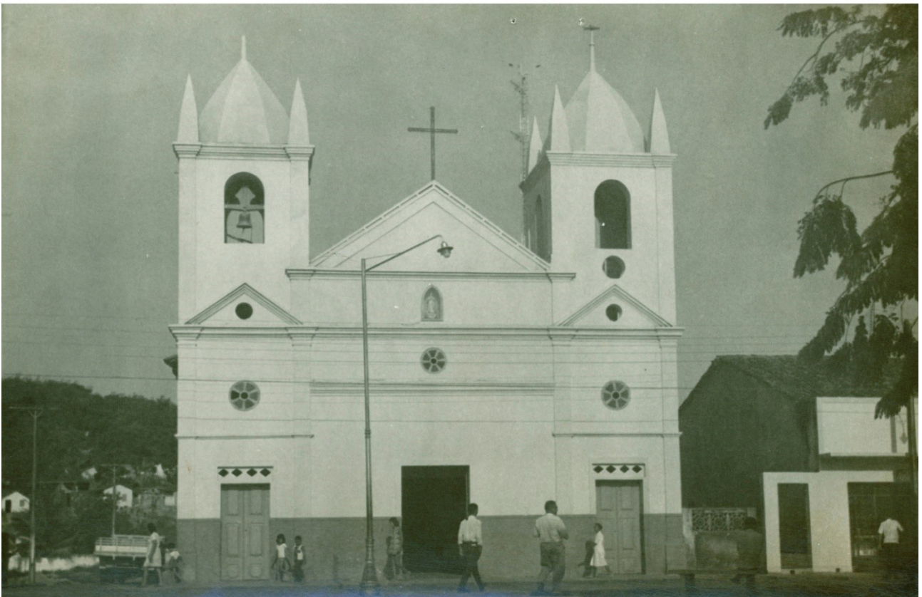
Figuras 71 e 72 – Igreja de Nossa Senhora da Conceição de Atalaia-AL em dois momentos: antes e após intervenções na fachada e acréscimo de torres. Monteiro (2018)
