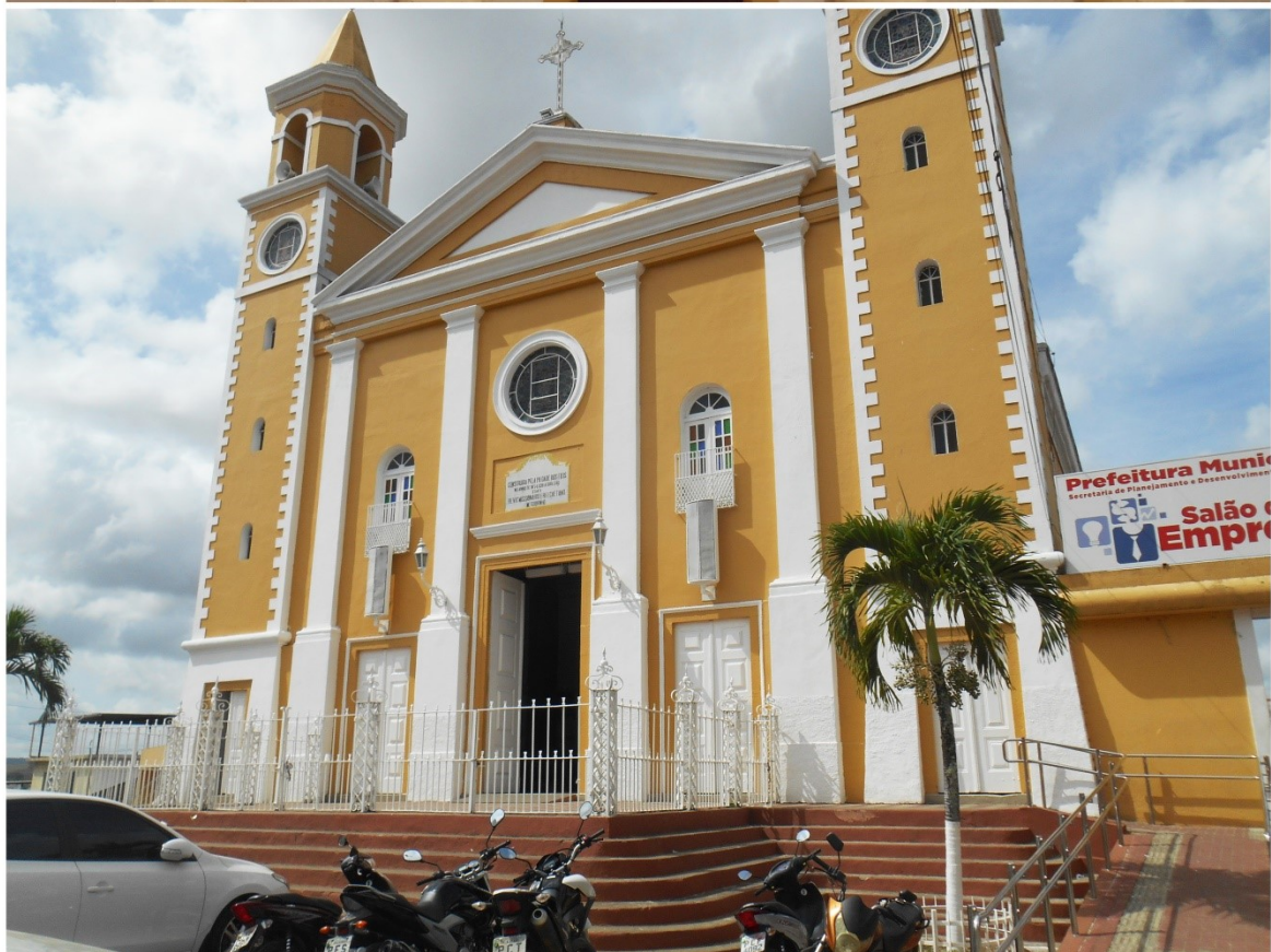
Figuras 98 e 99 – Acima, vista da fachada principal da igreja Matriz de Pilar-AL; abaixo, vista da fachada principal da igreja Matriz de Escada-PE. Ambas as matrizes intervencionadas em missões de Frei Caetano Sobrinho. Autor (2019) e Wikimedia Commons (2017)
