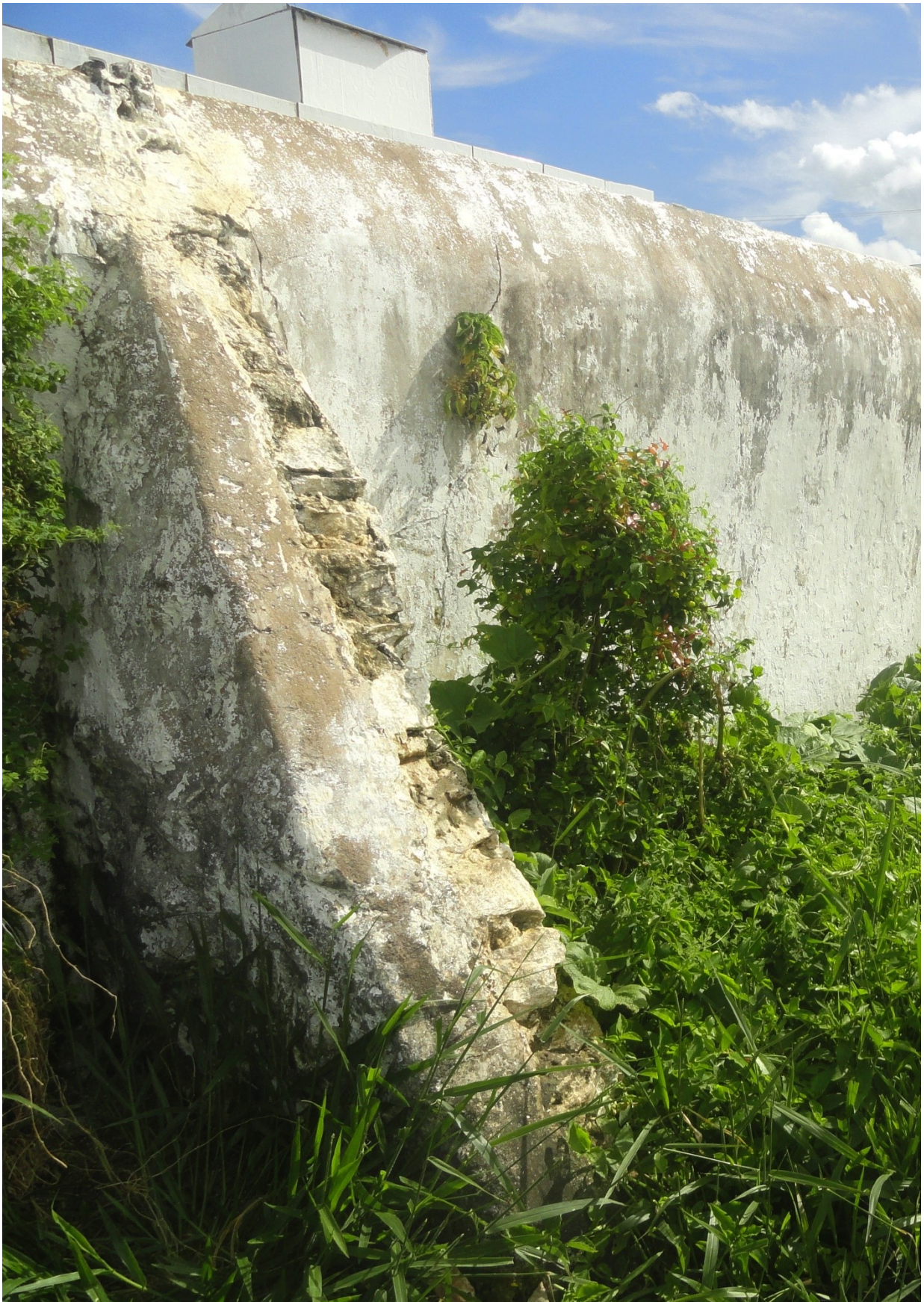
Figura 108 – Detalhe da alvenaria de pedra do muro do cemitério de Anadia-AL vista sob o reboco. Autor (2018)
