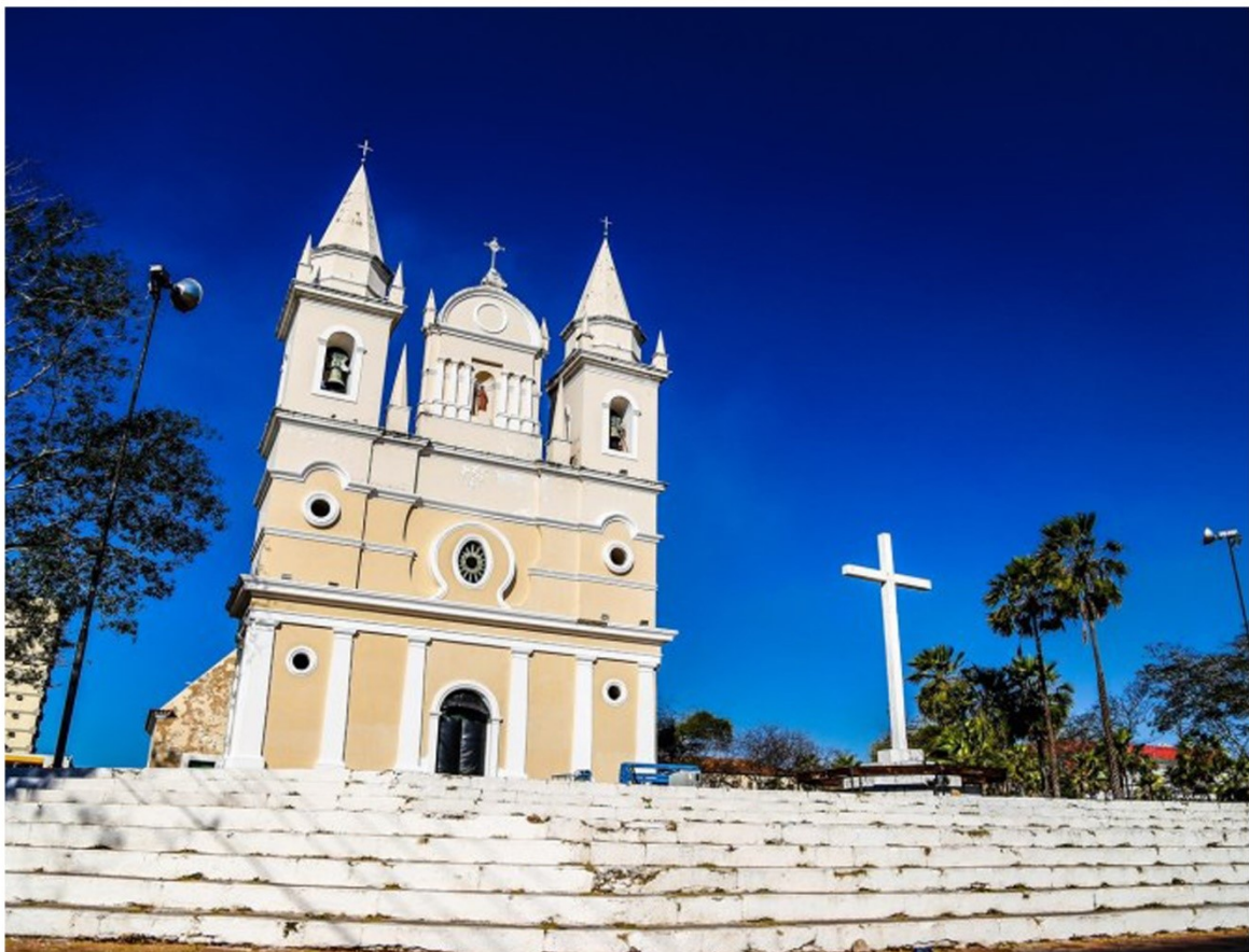
Figuras 100 e 101 – Vistas de igrejas intervencionadas pelas missões de Frei Seraphim de Catania: Matriz de Nossa Senhora da Conceição de Pedras de Fogo-PB e igreja São Benedito de Teresina-PI. Alcântara (2012) e Arquidiocese de Teresina (2019)
