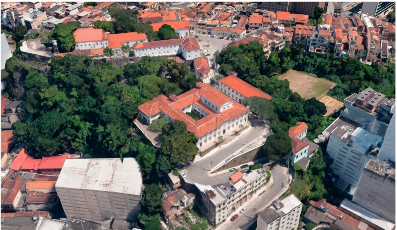
Figura 19 – Vista do Morro da Conceição da cidade do Rio de Janeiro. Ao centro da imagem, o atual Serviço Geográfico do Exército, anterior Palácio Episcopal e antigo Hospício Capuchinho de Nossa Senhora da Conceição. Adaptado de Google (2018)
