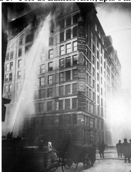
Figura 17- Foto do Edifício Asch , após o incêndio
