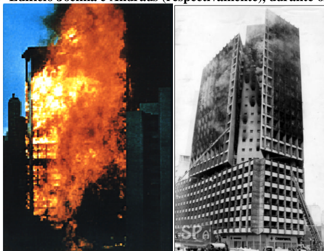
Figura 20- Edifício Joelma e Andraus (respectivamente), durante os incêndios
