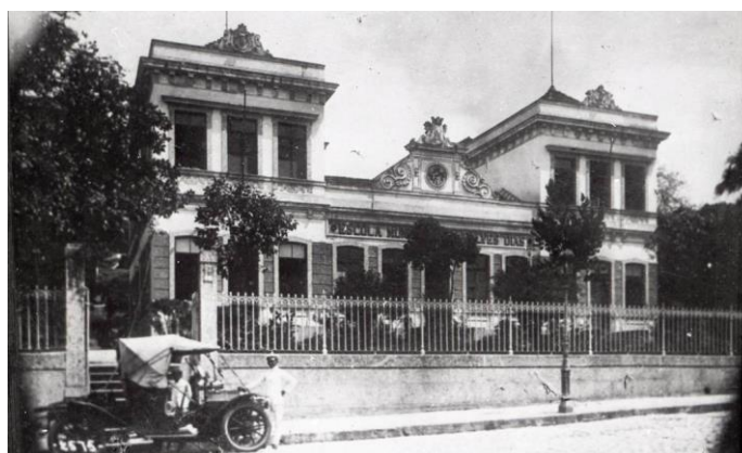
Figura 4- Fachada da Escola Municipal Gonçalves Dias, Rio de Janeiro
