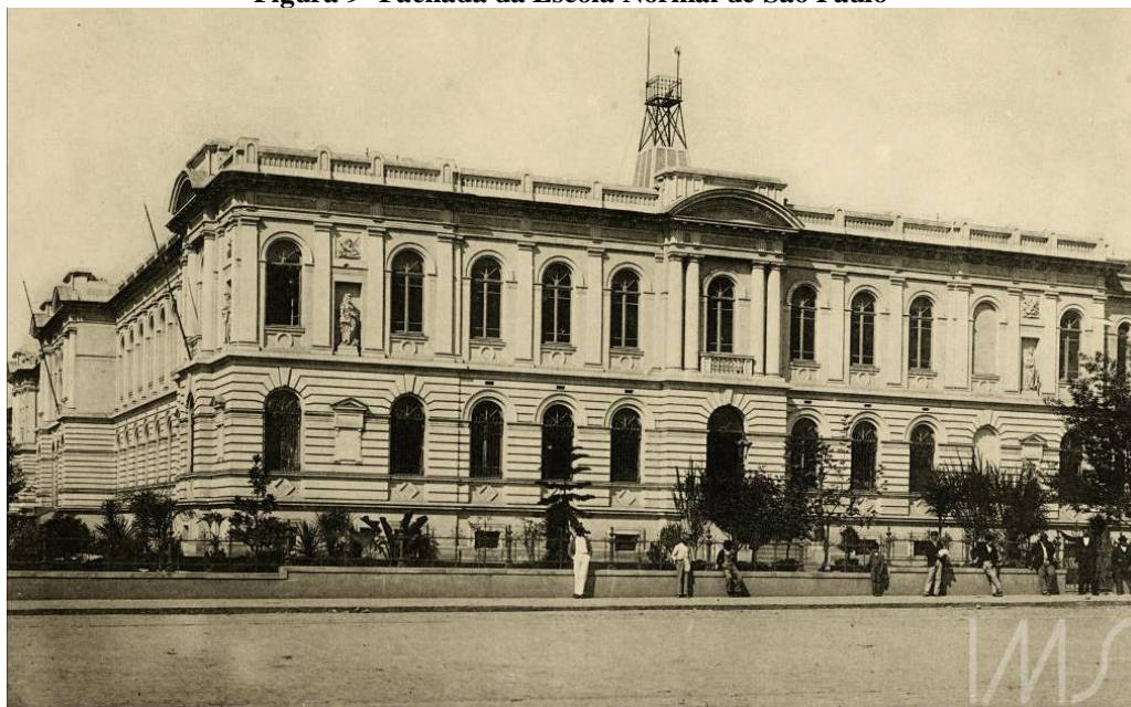
Figura 9- Fachada da Escola Normal de São Paulo
