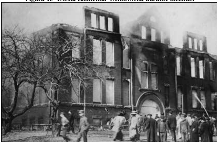
Figura 15- Escola Elementar Collinwood, durante incêndio
