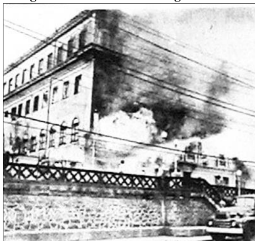
Figura 19- Incêndio no Colégio Pedro II
