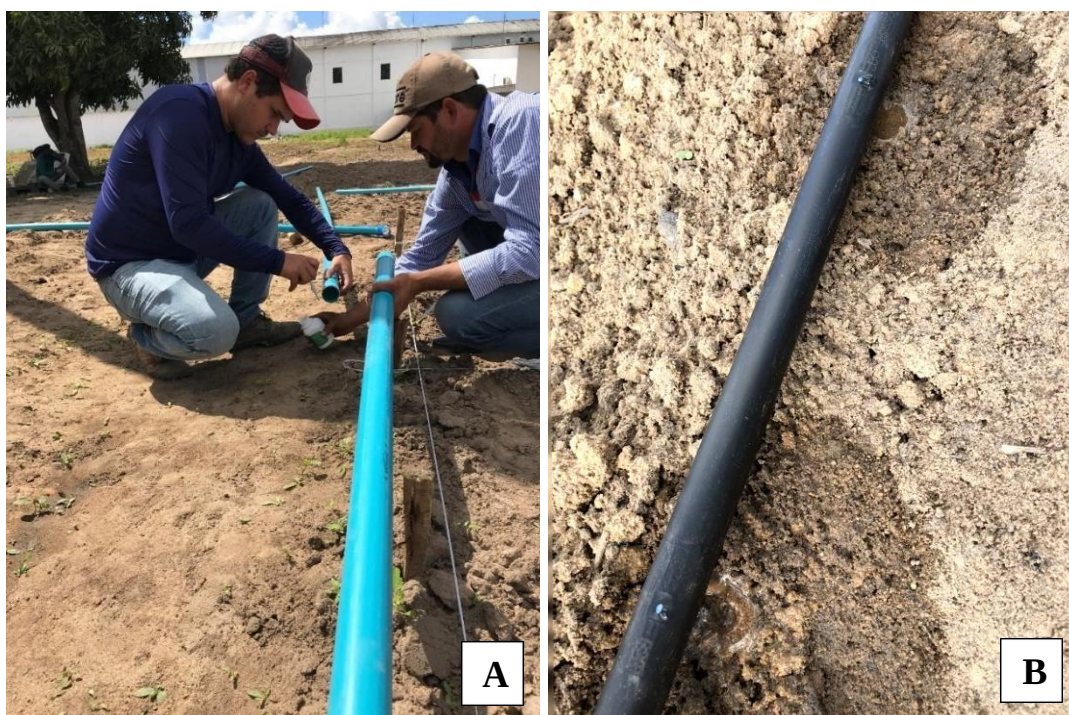
Figura 5. Instalação do sistema de irrigação (A). Fita gotejadora (B).
