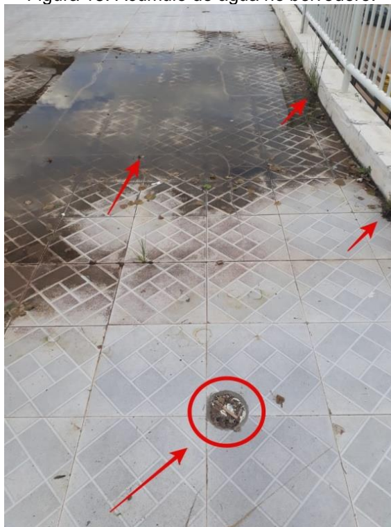
Figura 18: Acúmulo de água no belvedere.
