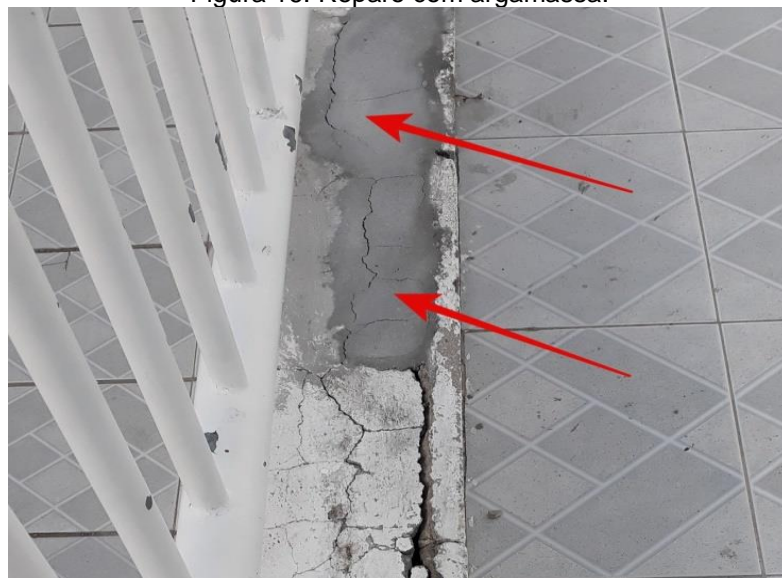
Figura 16: Reparo com argamassa.
