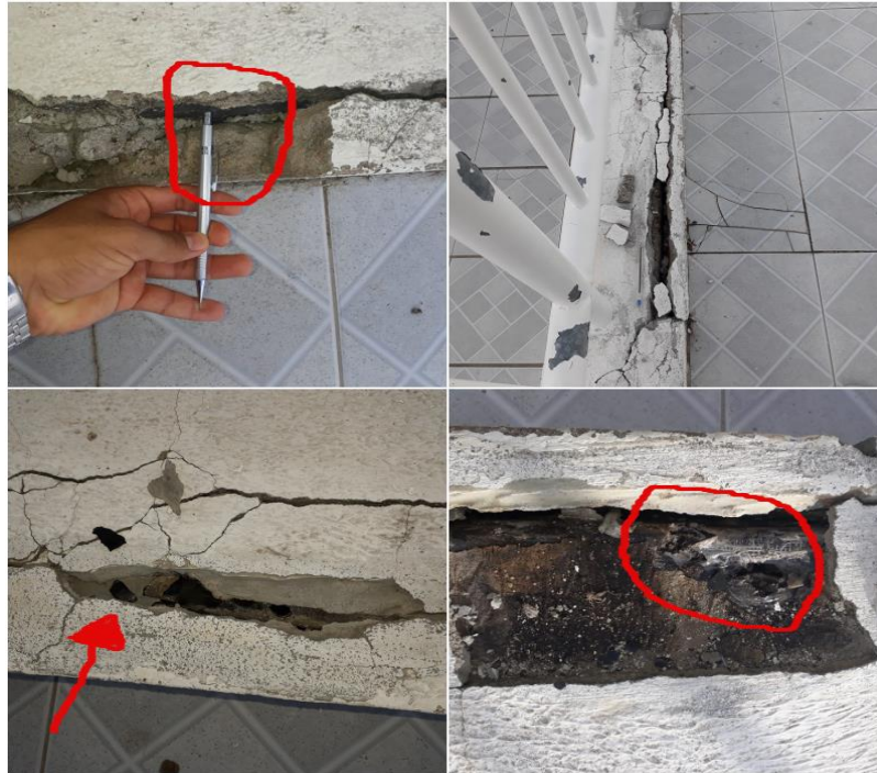
Figura 15: Destacamento da base do peitoril.
