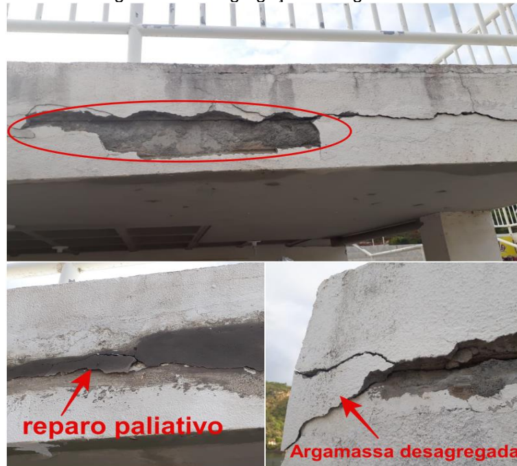
Figura 26: Desagregação da argamassa.
