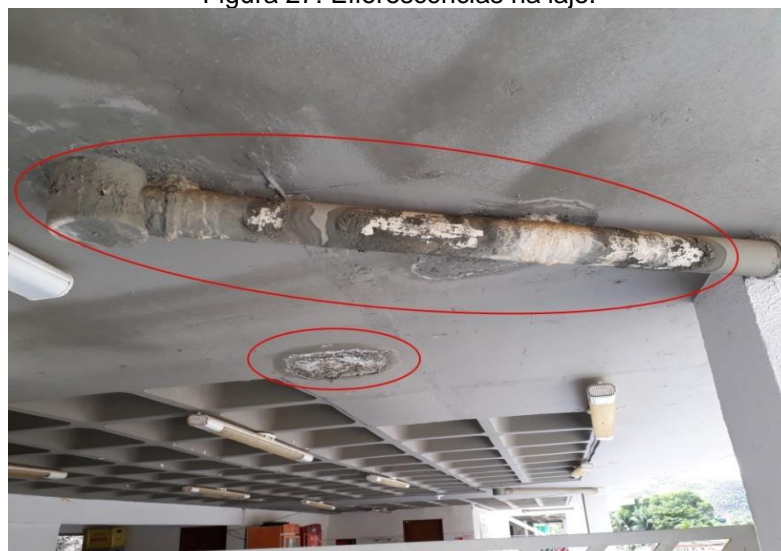
Figura 27: Eflorescências na laje.
