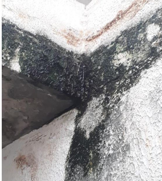
Figura 24: sujidade de origem biológica.
