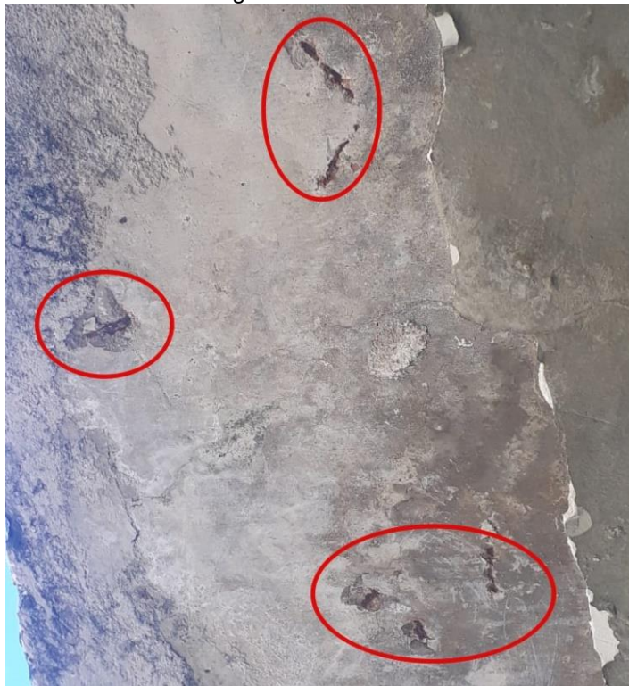
Figura 22: Corrosão.
