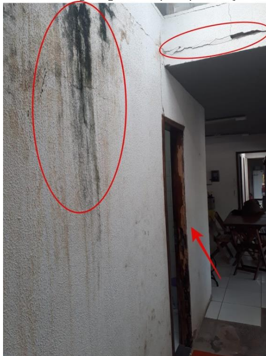
Figura 25: Patologias geradas pela presença de água.
