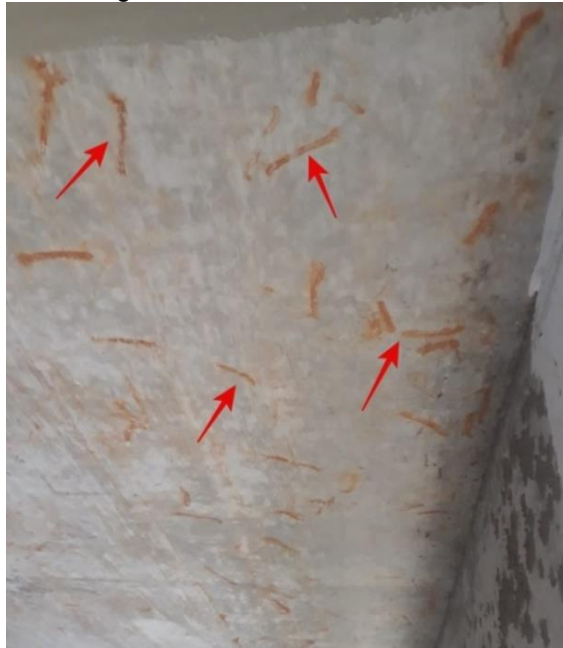
Figura 23: Manchas de corrosão.
