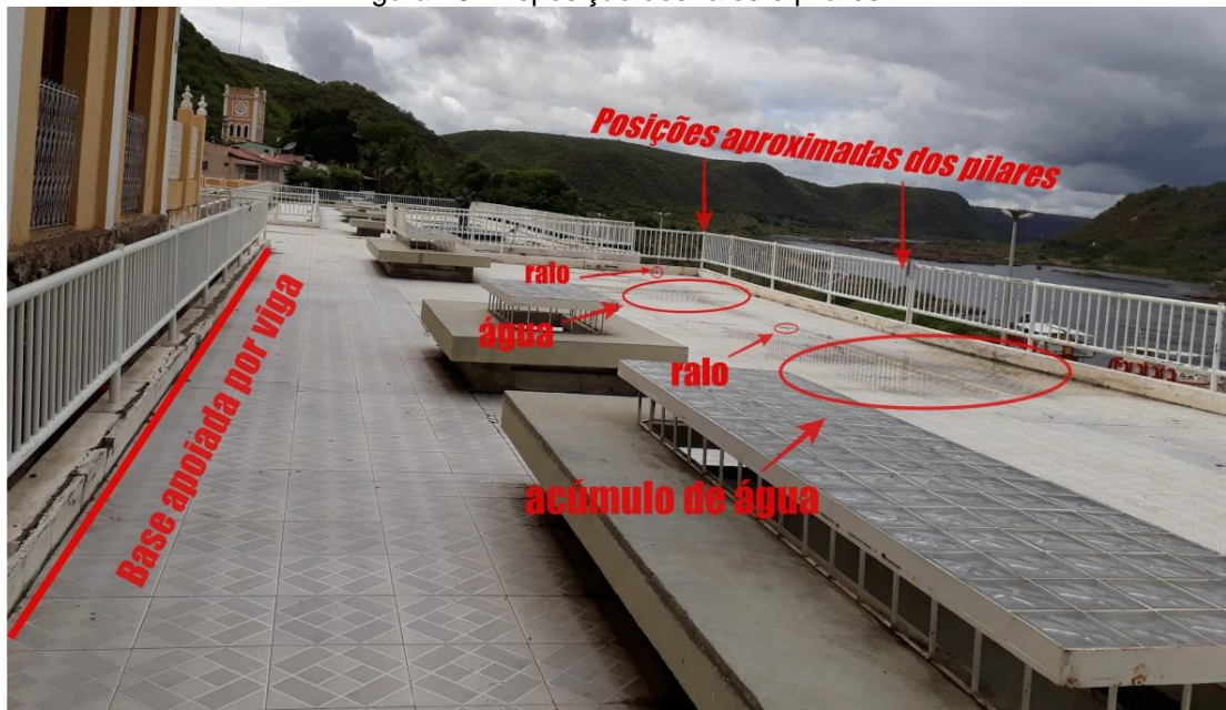
Figura 20: Disposição dos ralos e pilares.
