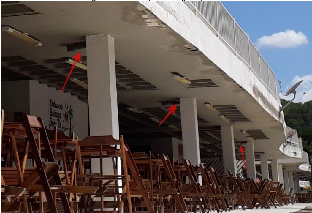
Figura 19: Tubulações de águas pluviais.
