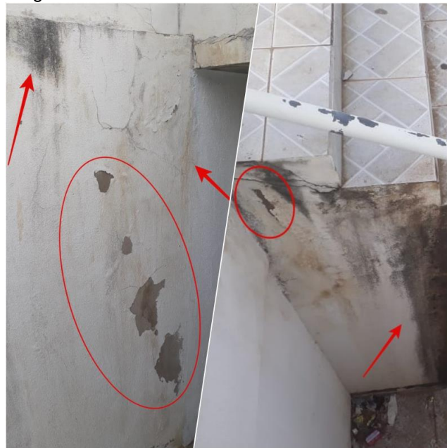
Figura 21: Manchas de umidade e descascamento.
