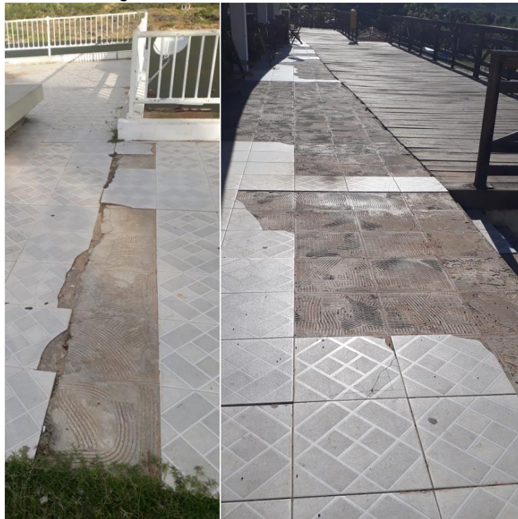
Figura 13: Destacamento da cerâmica.
