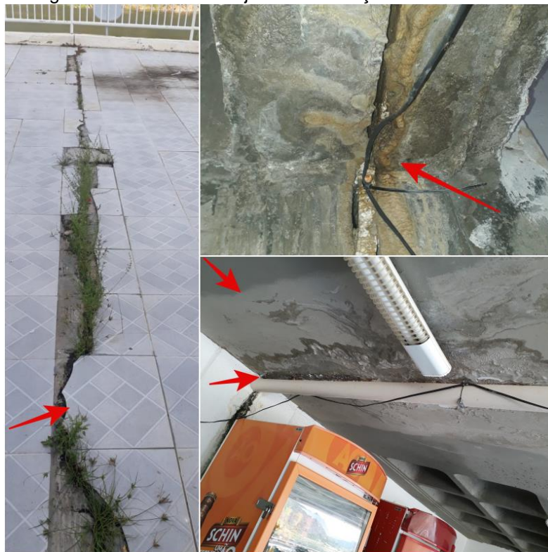
Figura 17: Problemas na junta de dilatação do belvedere 1.
