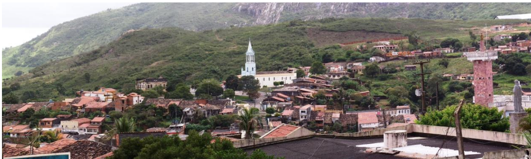
Figura 31 - Vista de uma porção da cidade de Mata Grande – AL. Predominância do padrão horizontal de ocupação.
