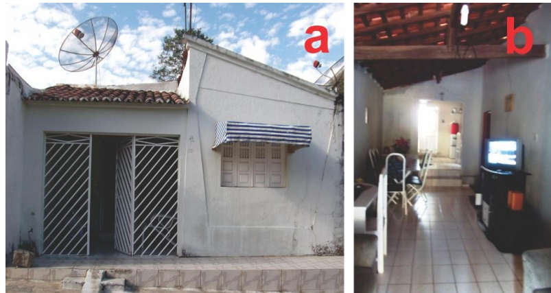
Figura 45 - Exemplo de habitação COHAB. (a) Fachada principal; (b) sala de estar.
