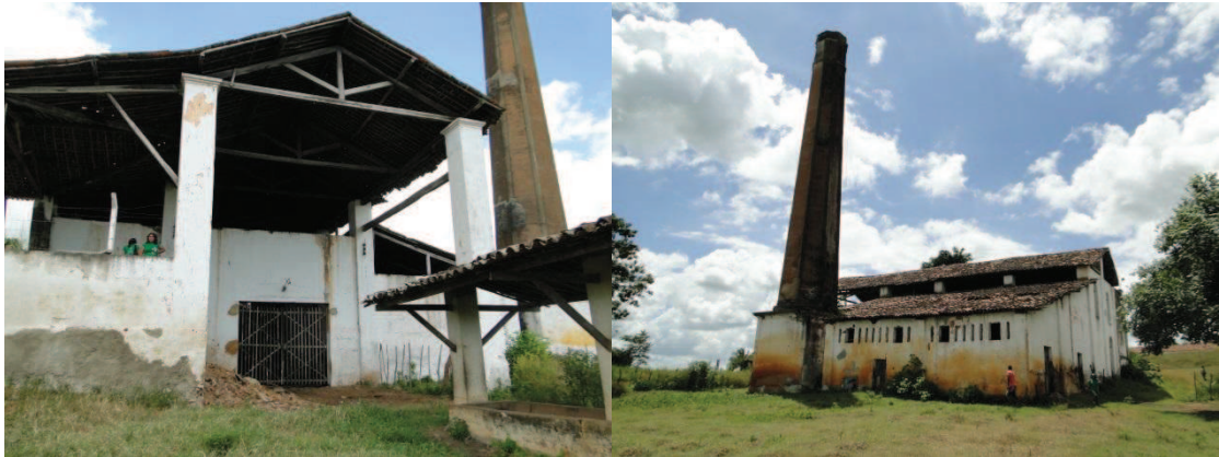
Figura 65: Edificação que compreendia a antiga usina Uruaé, localizada no engenho Uruaé em Vicência - PE. Fonte: Grupo de Pesquisa Estudos da Paisagem, 2012.
