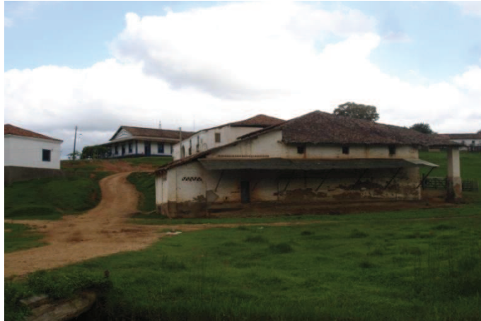
Figura 29: Conjunto das principais edificações do engenho Jundiá, localizado em Vicência - PE. Fonte: Grupo de Pesquisa Estudos da Paisagem, 2011.
