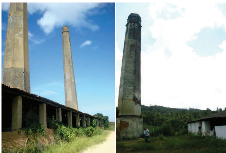
Figura 107: Engenho Mundaú, Satuba – AL. Bueiros localizados no galpão identificado como a fábrica e detalhe da base do bueiro, indícios da caldeira de um engenho a vapor. Fonte: Grupo de Pesquisa Estudos da Paisagem, 2010.
