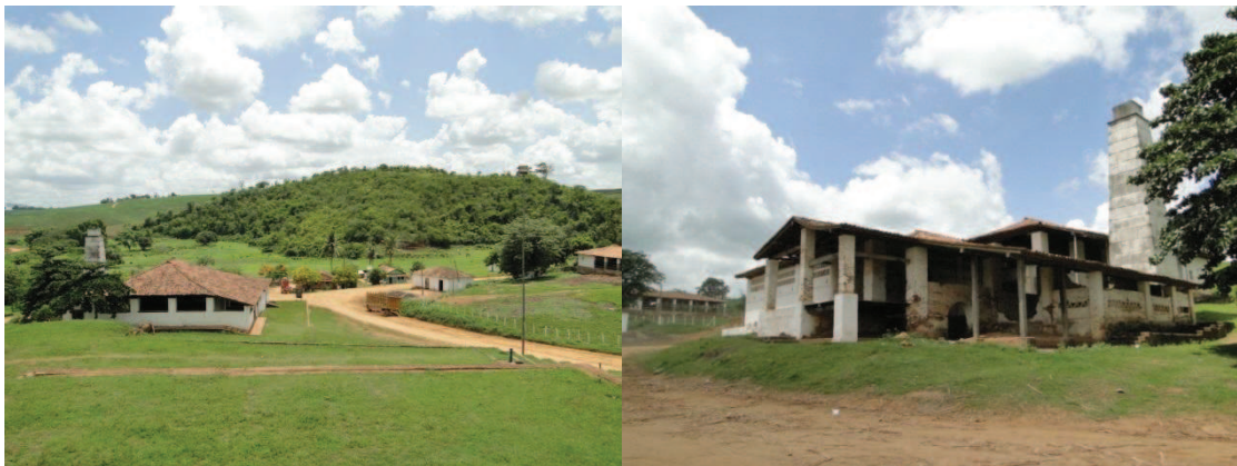
Figura 58: Engenho Poço Comprido, Vicência - PE. Fábrica do antigo engenho. Fonte: Grupo de Pesquisa Estudos da Paisagem, 2011.
