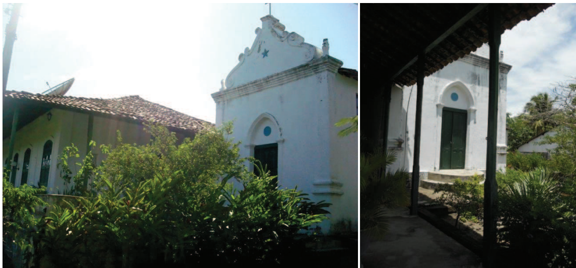
Figura 91: Capela do engenho Novo, Pilar - AL. Fachada principal da capela. Fonte: Grupo de Pesquisa Estudos da Paisagem, 2010.
