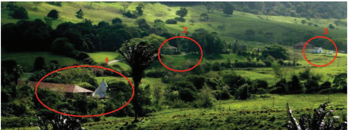
Figura 80: Engenho Varrela, São Miguel dos Campos. 1. Localização da antiga fábrica; 2. Casa-grande e 3. Capela
