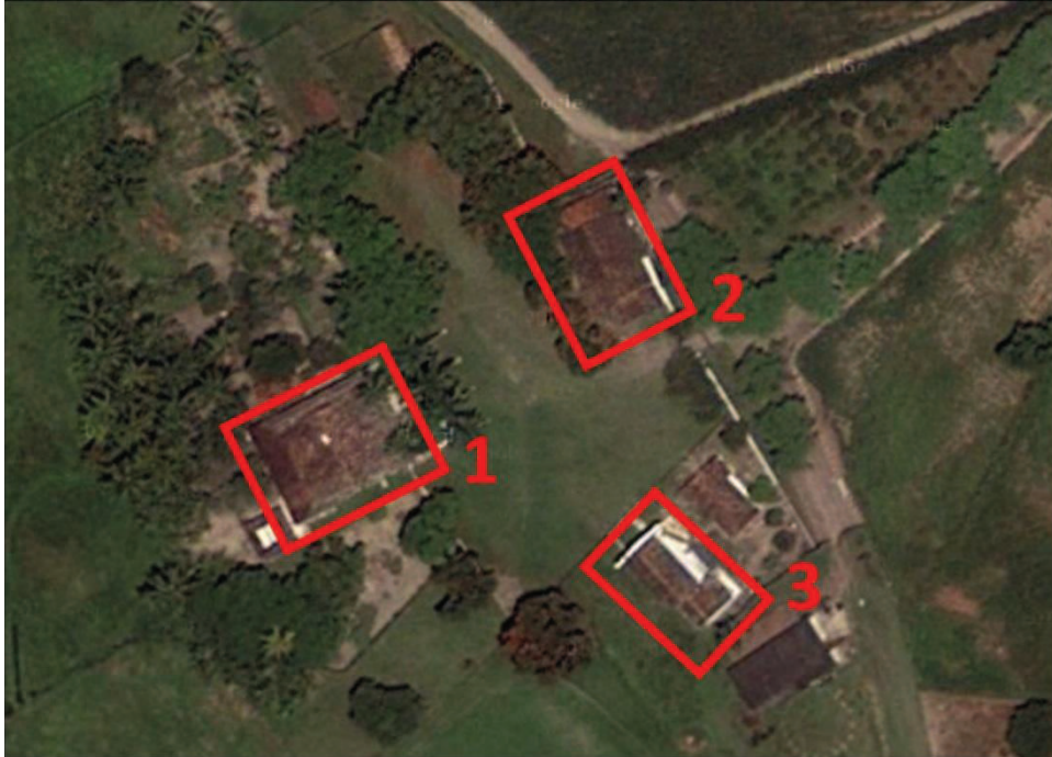
Figura 78: Vista do conjunto edificado do engenho Lamarão localizado em Pilar - AL. 1) Casa-grande. 2) Casa de trabalhadores ou senzala. 3) Capela
