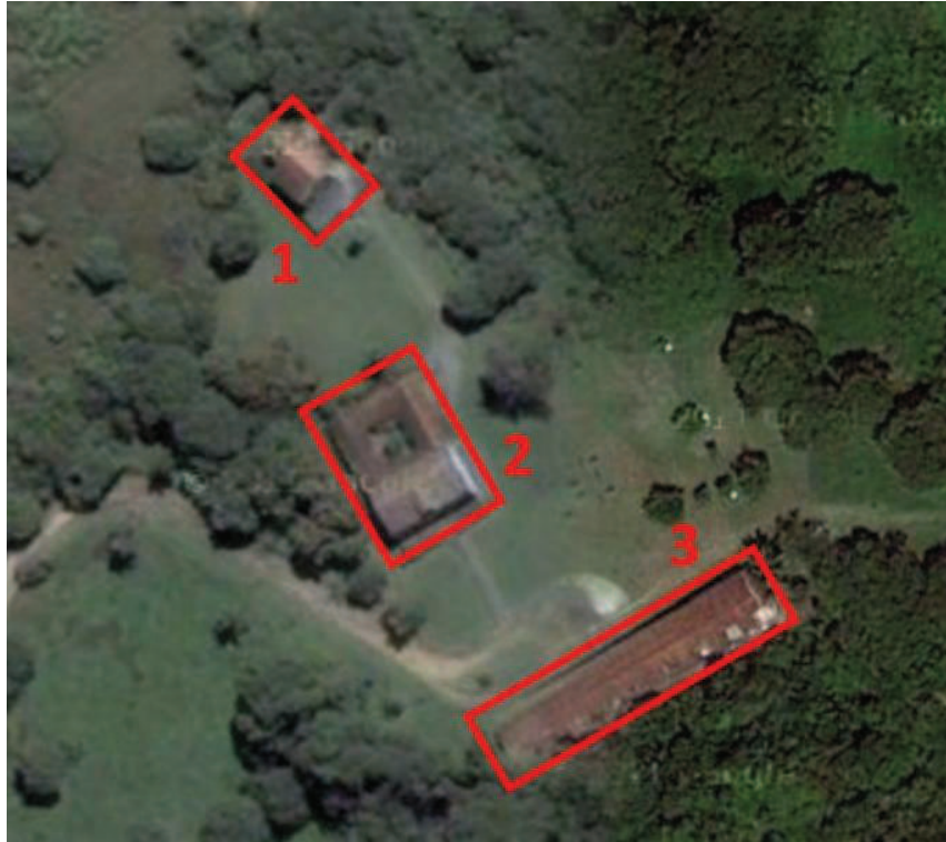
Figura 27: Vista aérea do conjunto e dos terrenos do engenho Massangana, localizado em Cabo de Santo Agostinho-PE. 1) Capela. 2) Casa-grande. 3) Casa de trabalhadores ou senzala.
