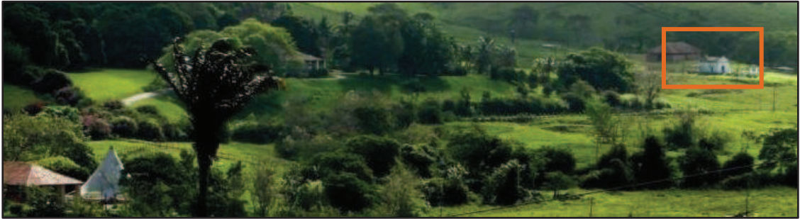
Figura 97: Destaque para a capela do engenho Varrela, e seu distanciamento das outras construções do conjunto.
