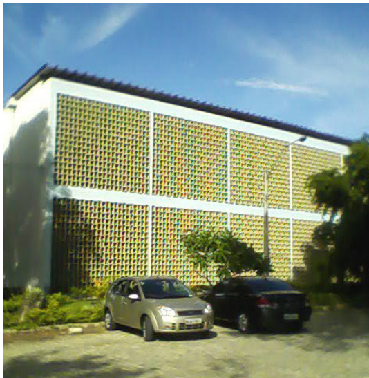
Figura 2 - Exemplo de proteção solar com cobogós (a) e brises horizontais fixos (b)
