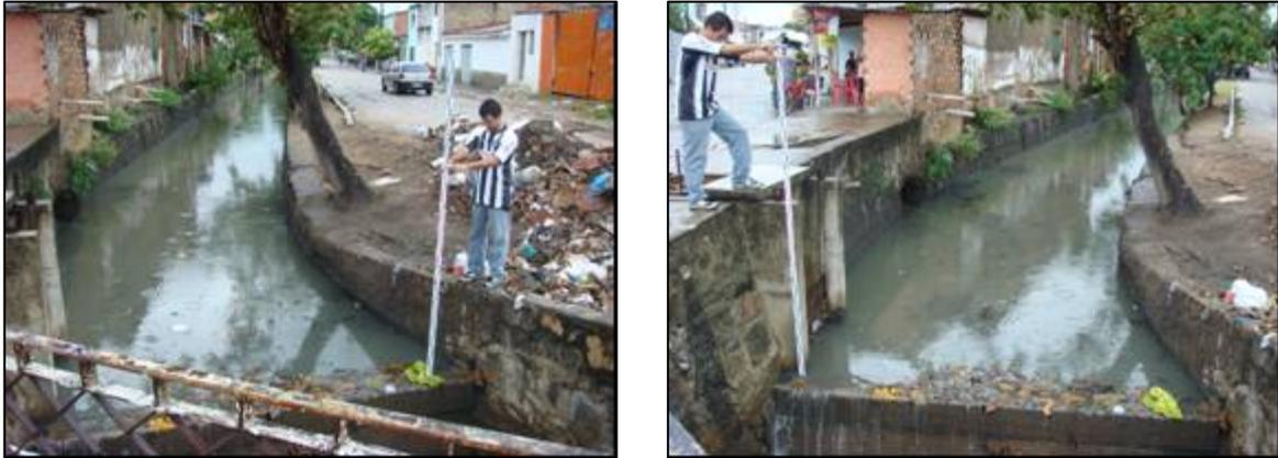
Figura 4.4. Fotografia da colocação da régua para estimativa dos níveis de água no riacho Gulandim
