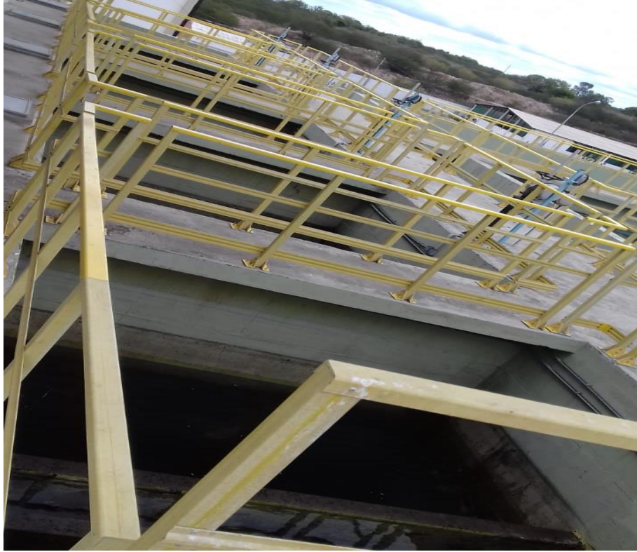
Figura 5: Unidades de filtração mostrada em um lado da ETA, vista 01. Fonte: Autor.
