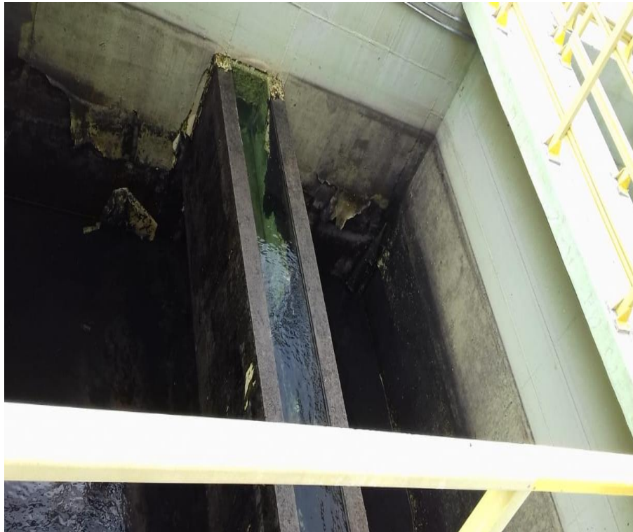
Figura 6: Uma das unidades de Filtração da ETA, vista 02. Fonte: Autor.
