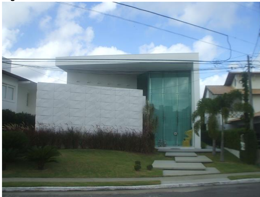
Figura 32 - Residência no Condomínio Aldebaran - Maceió/AL.
