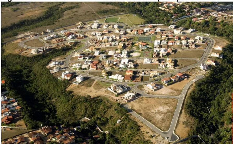
Figura 36 - Vista aérea do Lot. San Nicolás (2008)
