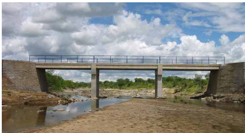
Figura 21 – Ponte sobre o Rio Jacaré permitindo o acesso ao Projeto de Assentamento Serrote das Aroeiras-AL.
