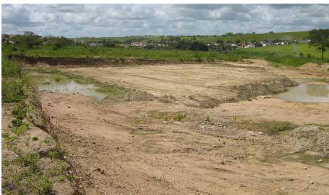
Figuras 24 e 25 – Local de instalação da ETE da cidade de Jacaré dos Homens e escavação das lagoas de estabilização.
